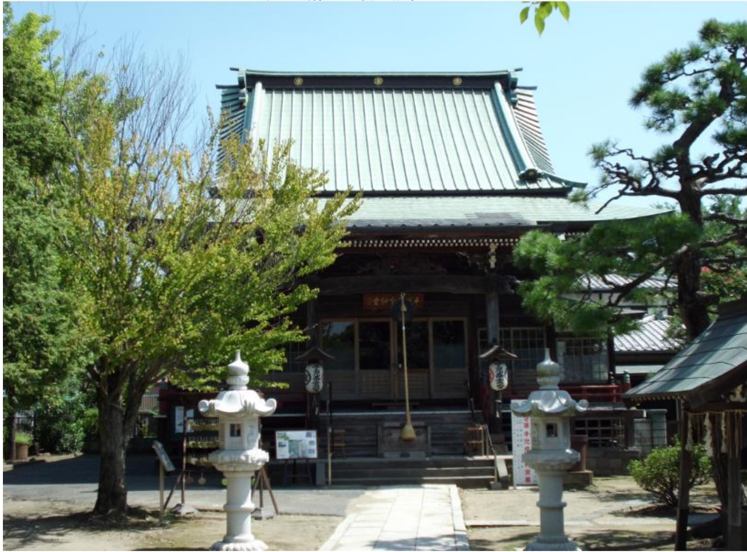
木造で銅板の屋根は鍔葺きとなっている
