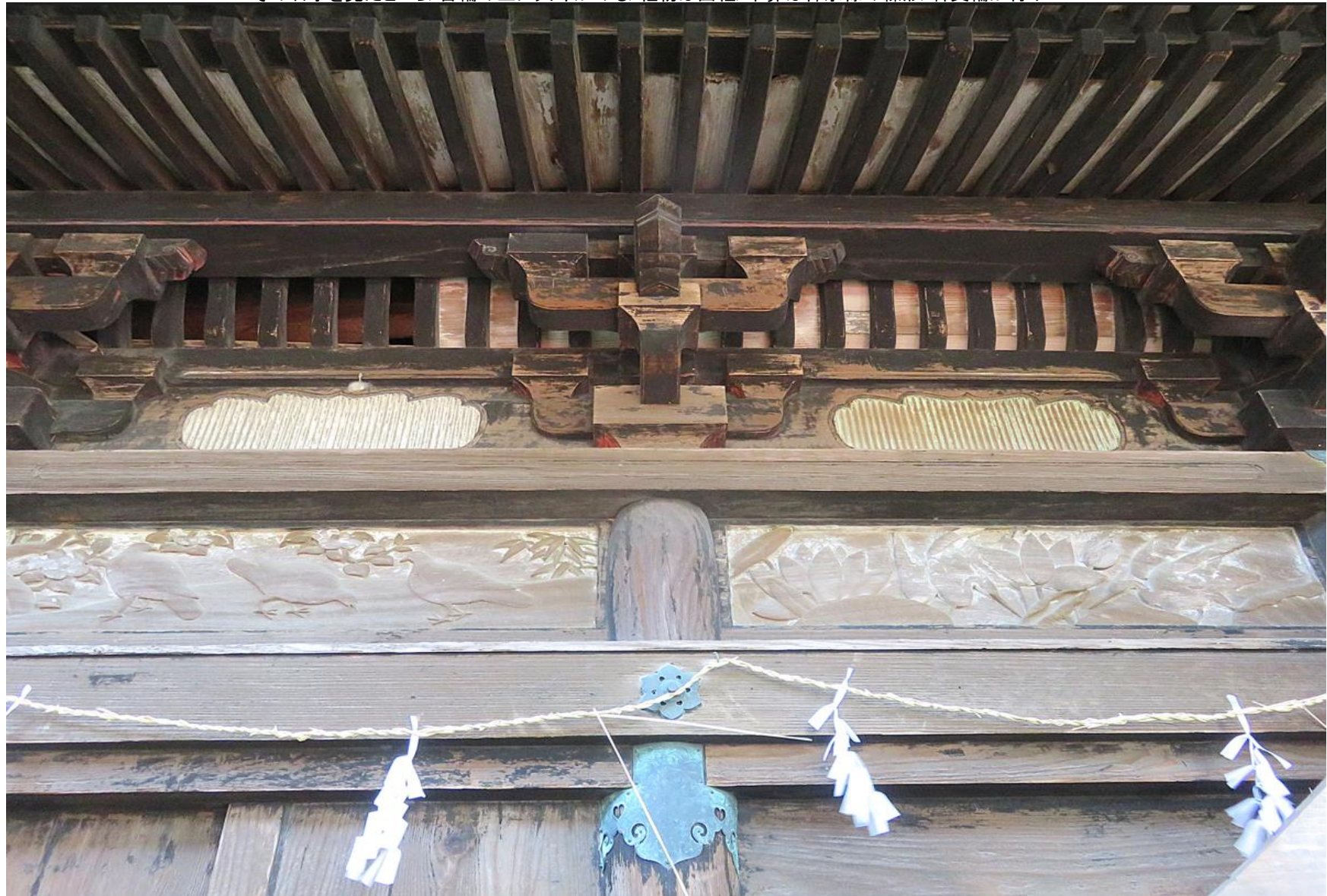
その右手を見たところ/台輪の上に大斗がのる/組物は出組/木鼻は禅宗様の繰形/軒支輪が付く
