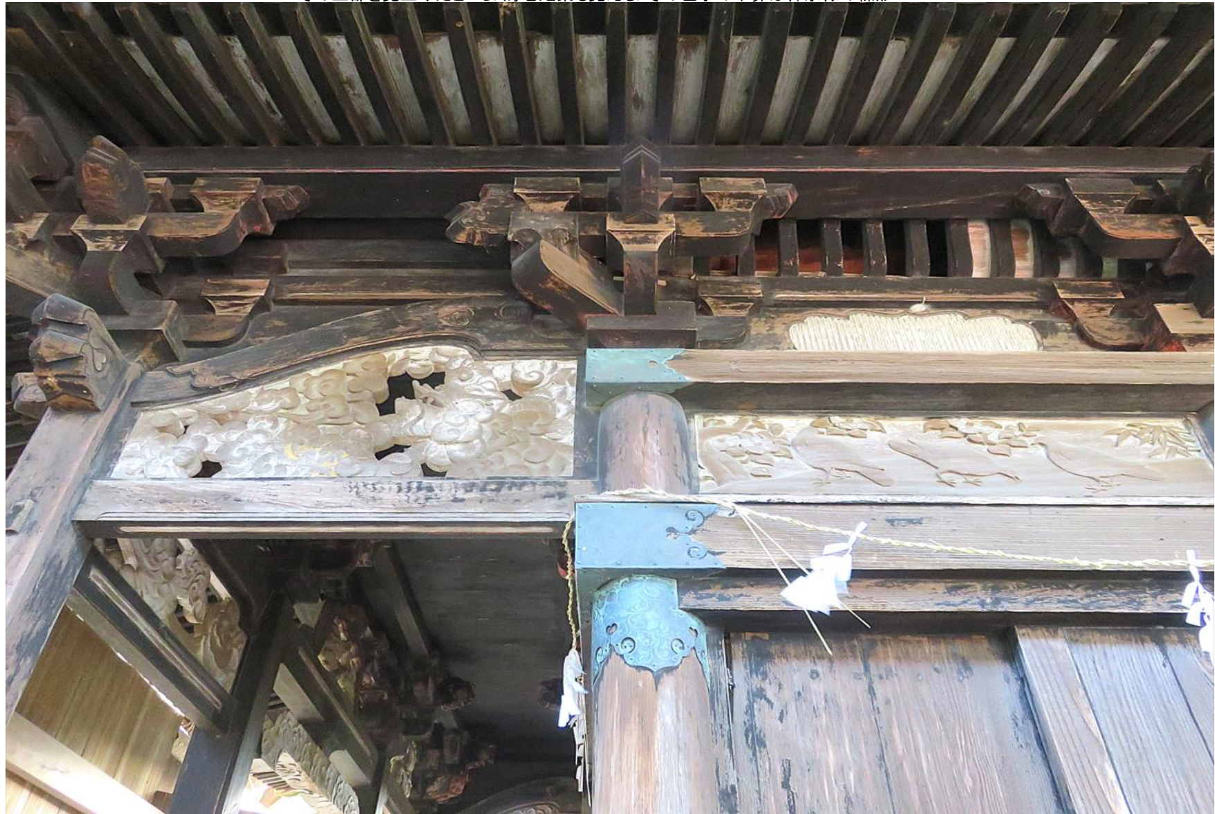
その上部を見上げたところ/海老虹梁も見える/その左手の木鼻は禅宗様の繰形
