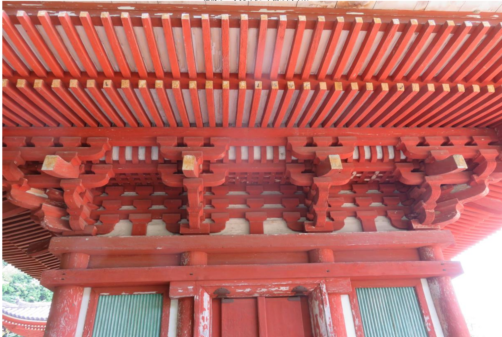
組物は三手先斗栱/中備は間斗束
