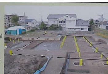
建物D(南から)
