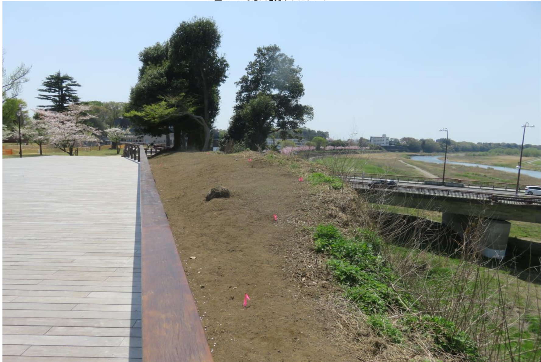
土塁の上から思川を見下ろしたところ
