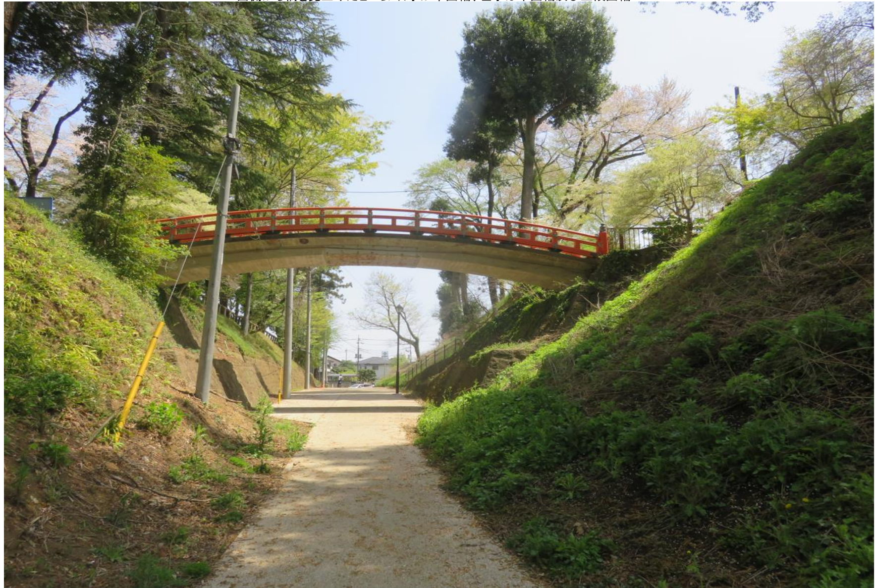
西側から橋を見上げたところ/右手が本曲輪、左手は中曲輪及び上段曲輪
