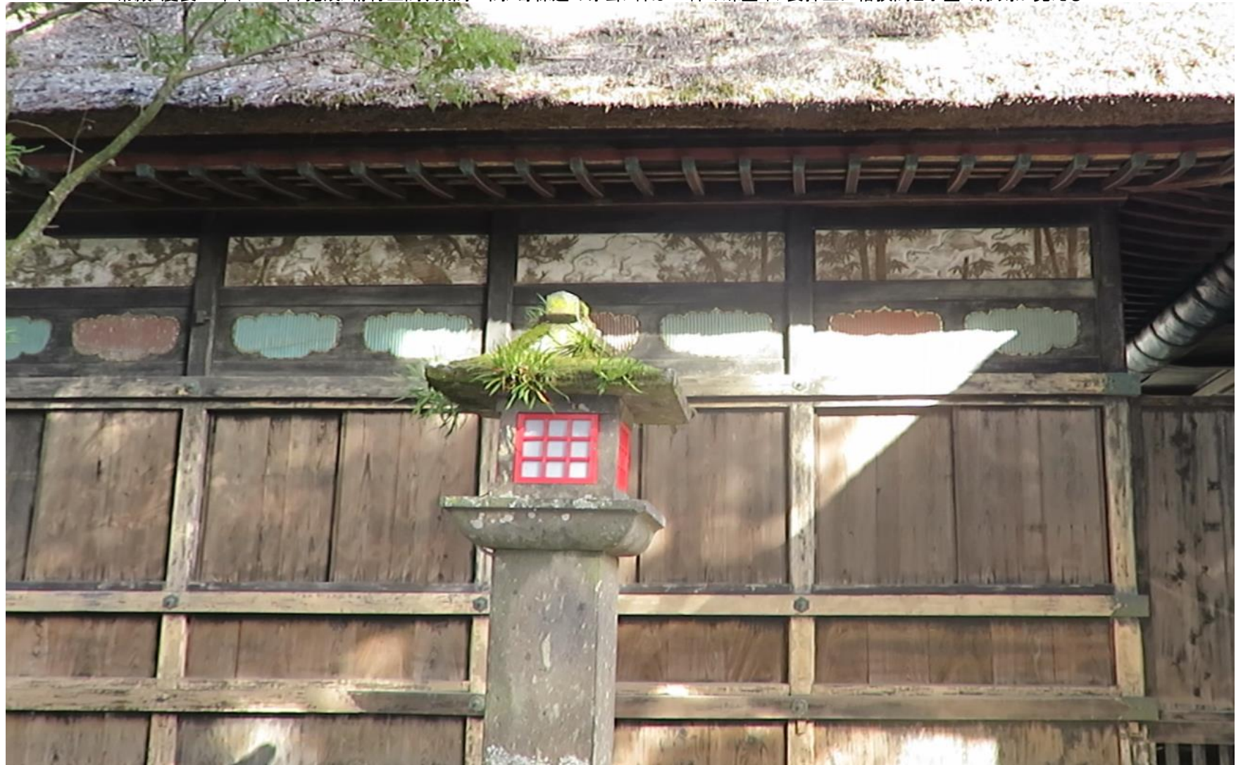
幣殿/慶長15年(1610年)完成/桁行五間、梁間三間/寄棟造の茅葺/軒は一軒の疎垂木/長押上に格狭間と小壁の彫刻が見える
