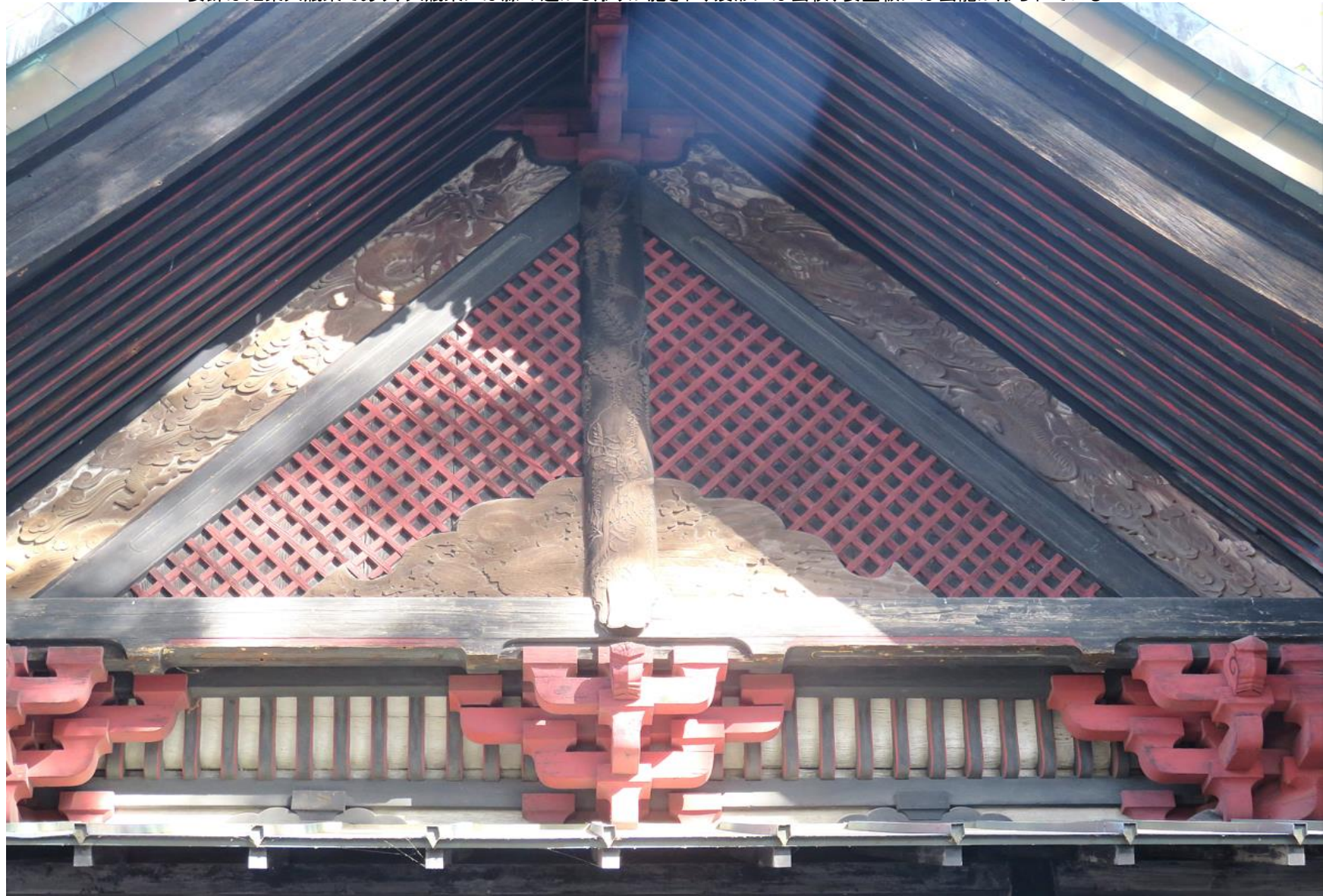
妻飾は虹梁大瓶束であり、大瓶束には藤の透かし彫りが施され、笄形には雲紋、妻壁板には雲龍が彫られている
