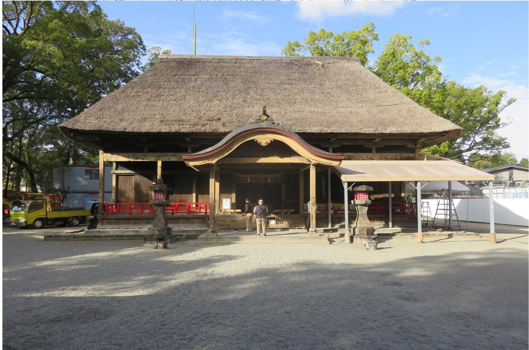
拝殿/慶長16年(1611年)完成/桁行7間、梁間3間/寄棟造の茅葺/唐破風の向拝が付く/軒は出桁造
