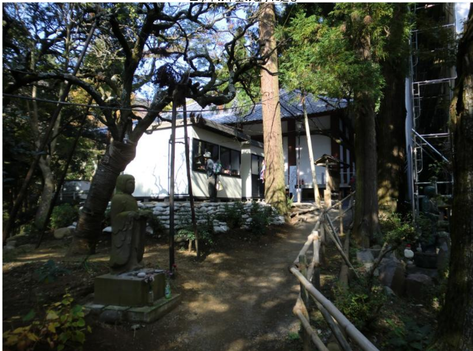
工事中の本堂の左手に進む
