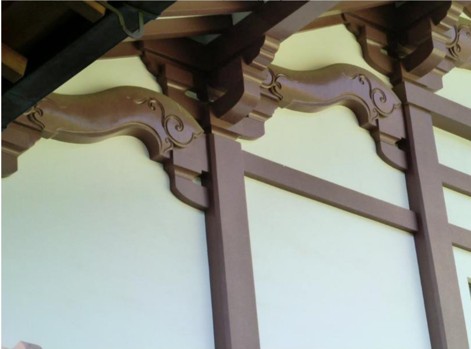
妻壁面が大きいので海老虹梁が二列に入っている
