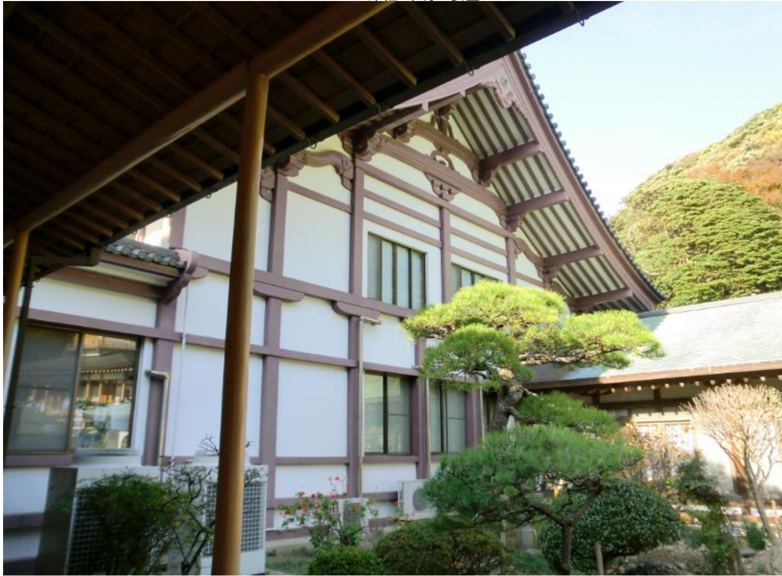
これだけの大きな壁面での縦横の部材とそれに区切られた白壁とのバランスが絶妙である
