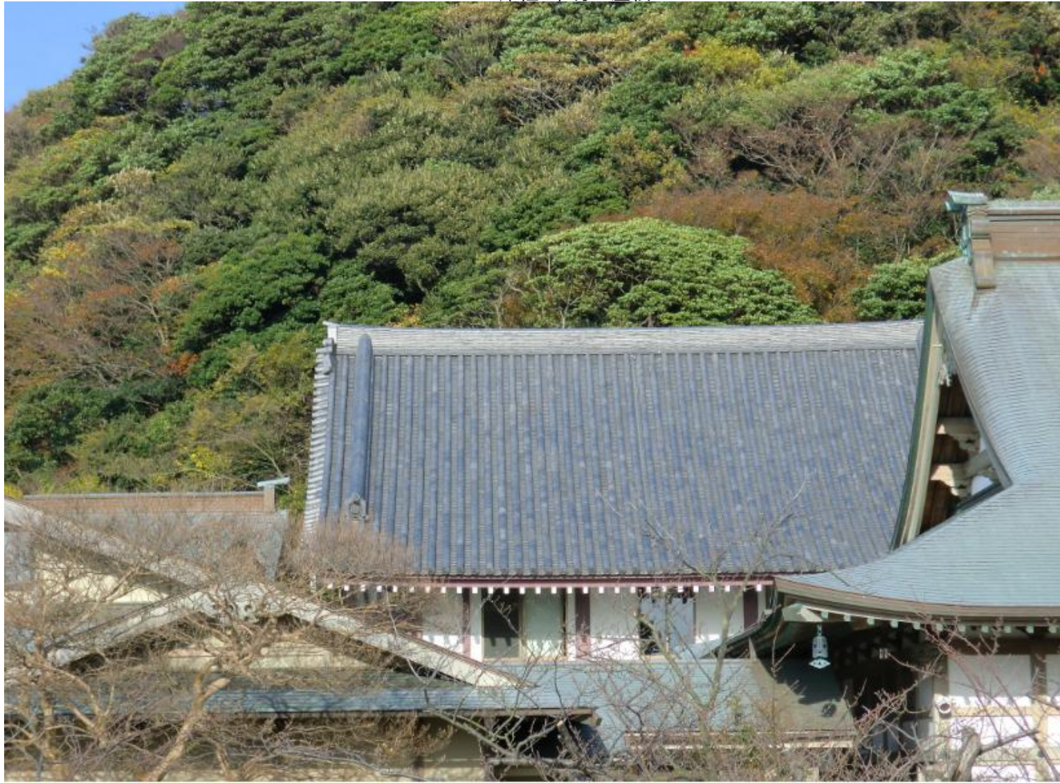
庫裡・本坊の屋根
