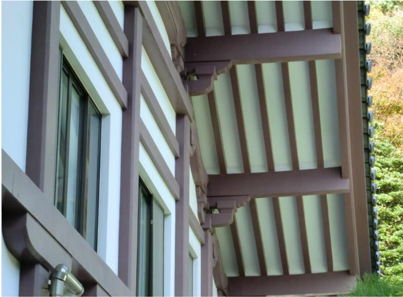
跳ね出しの桁は出三斗で受けた形
