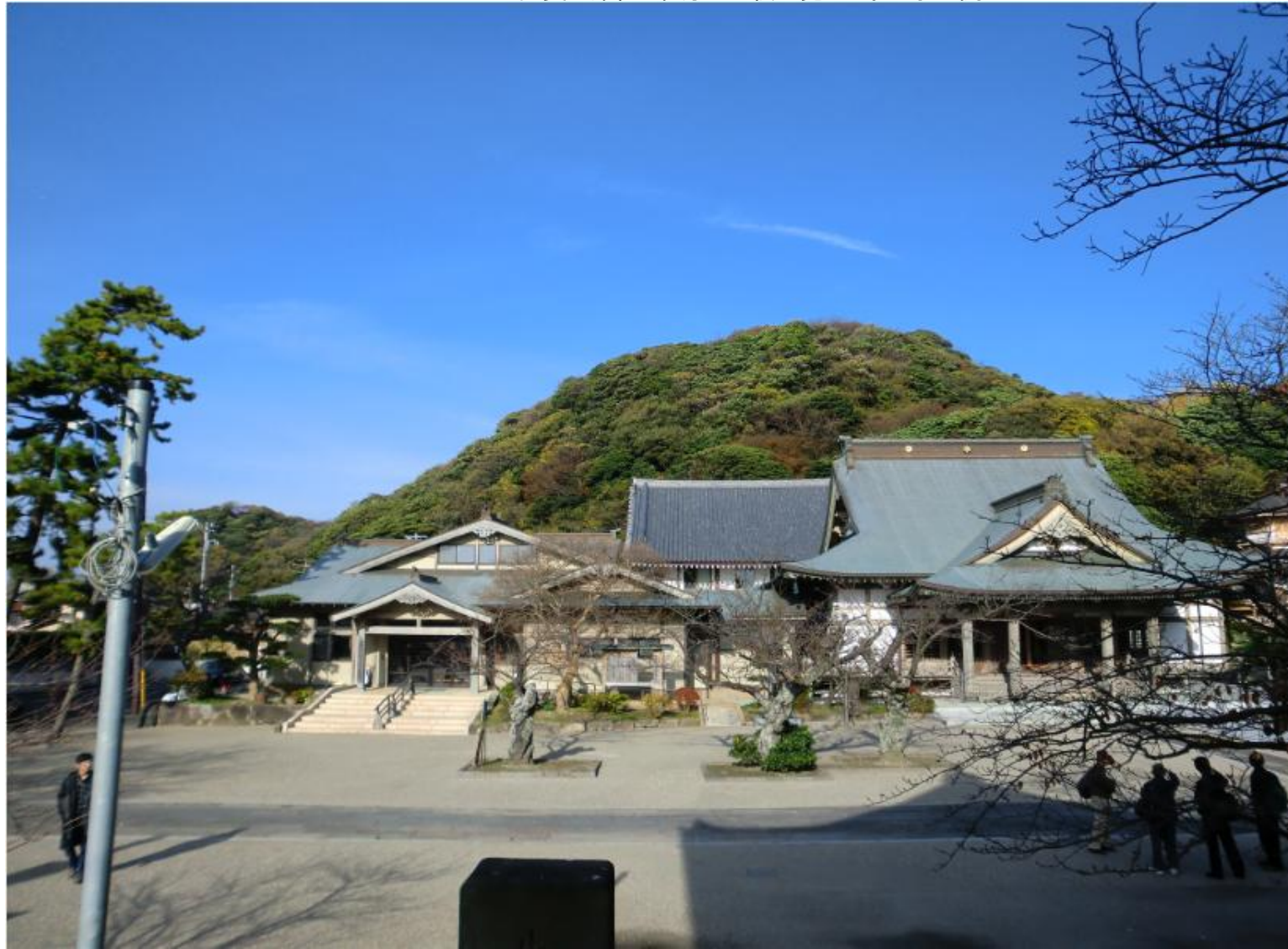
正面奥に庫裡・本坊の屋根が見える。右手は開山堂
