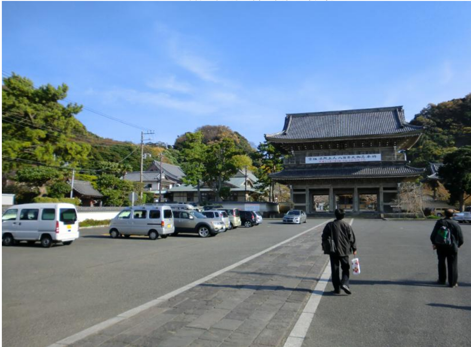
三門、左手遠方に庫裡・本坊の屋根が見える
