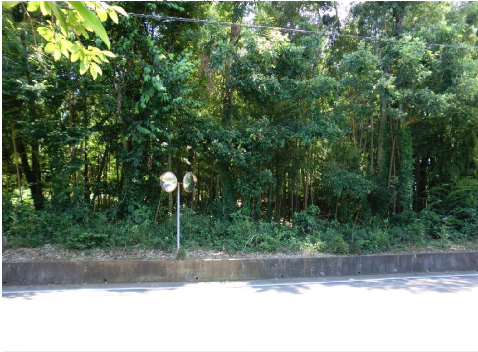
道路をはさんだ竹林/地盤が約50cmほど高くなっている
