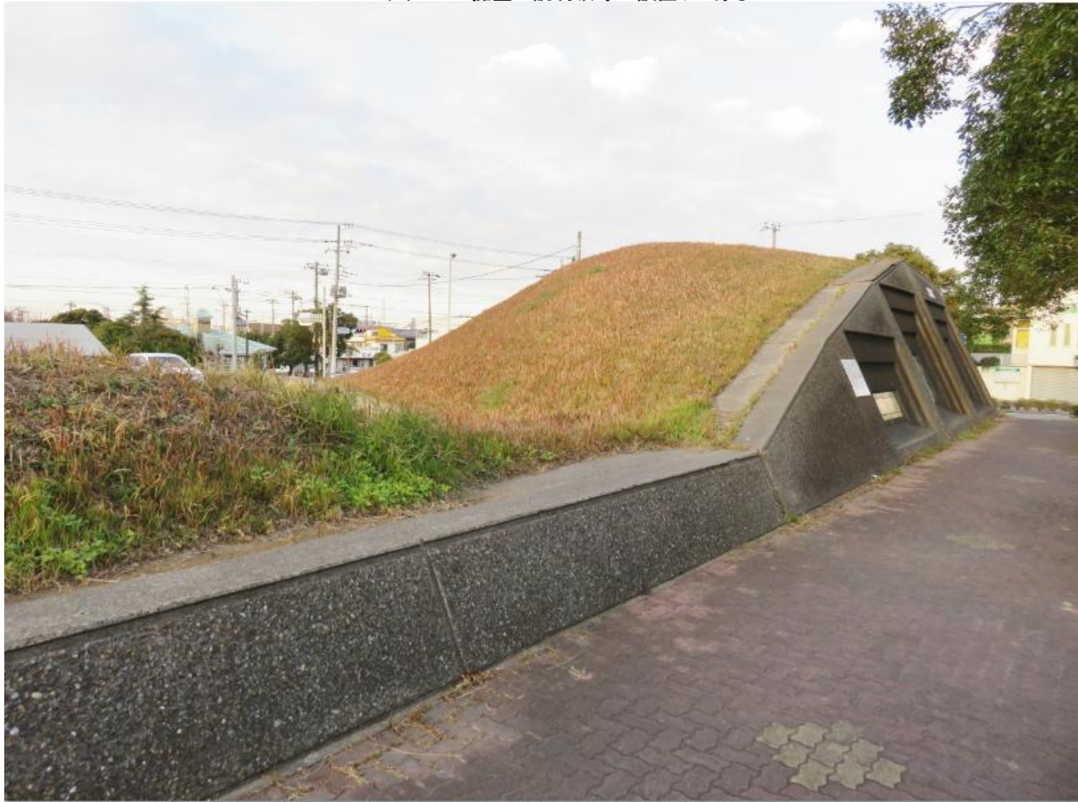
コンクリートの擁壁に説明坂等が設置してある
