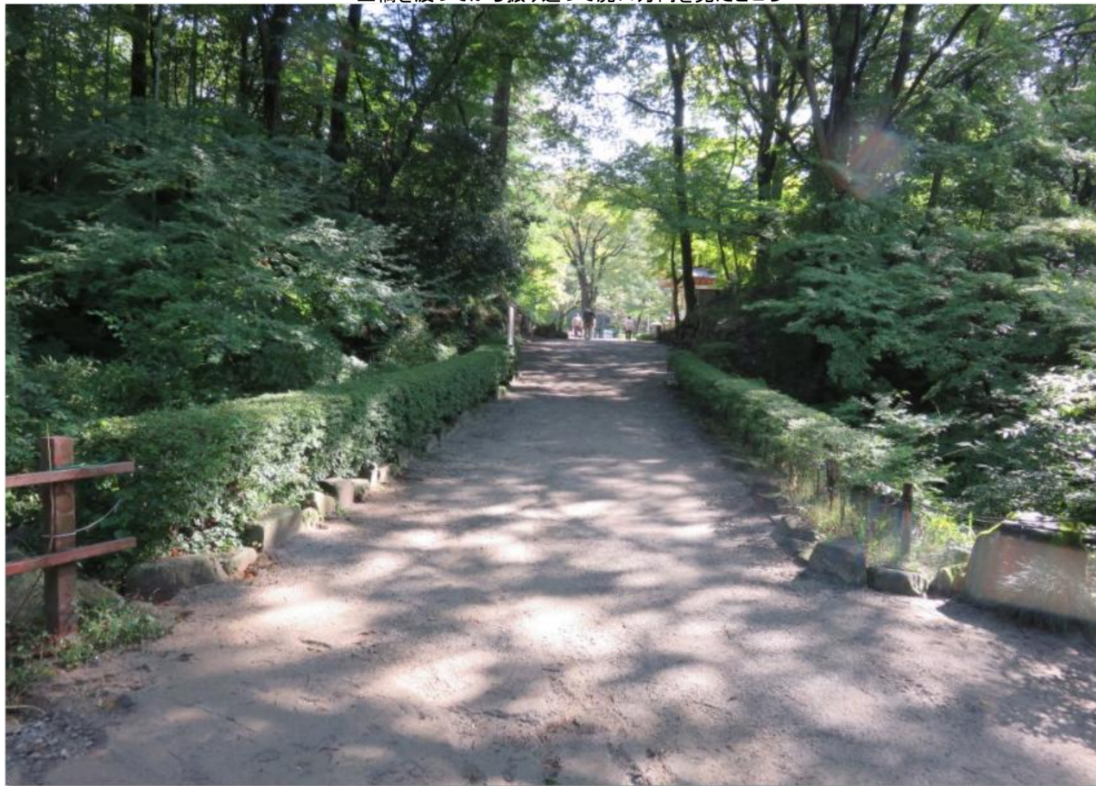
土橋を渡ってから振り返って虎口方向を見たところ
