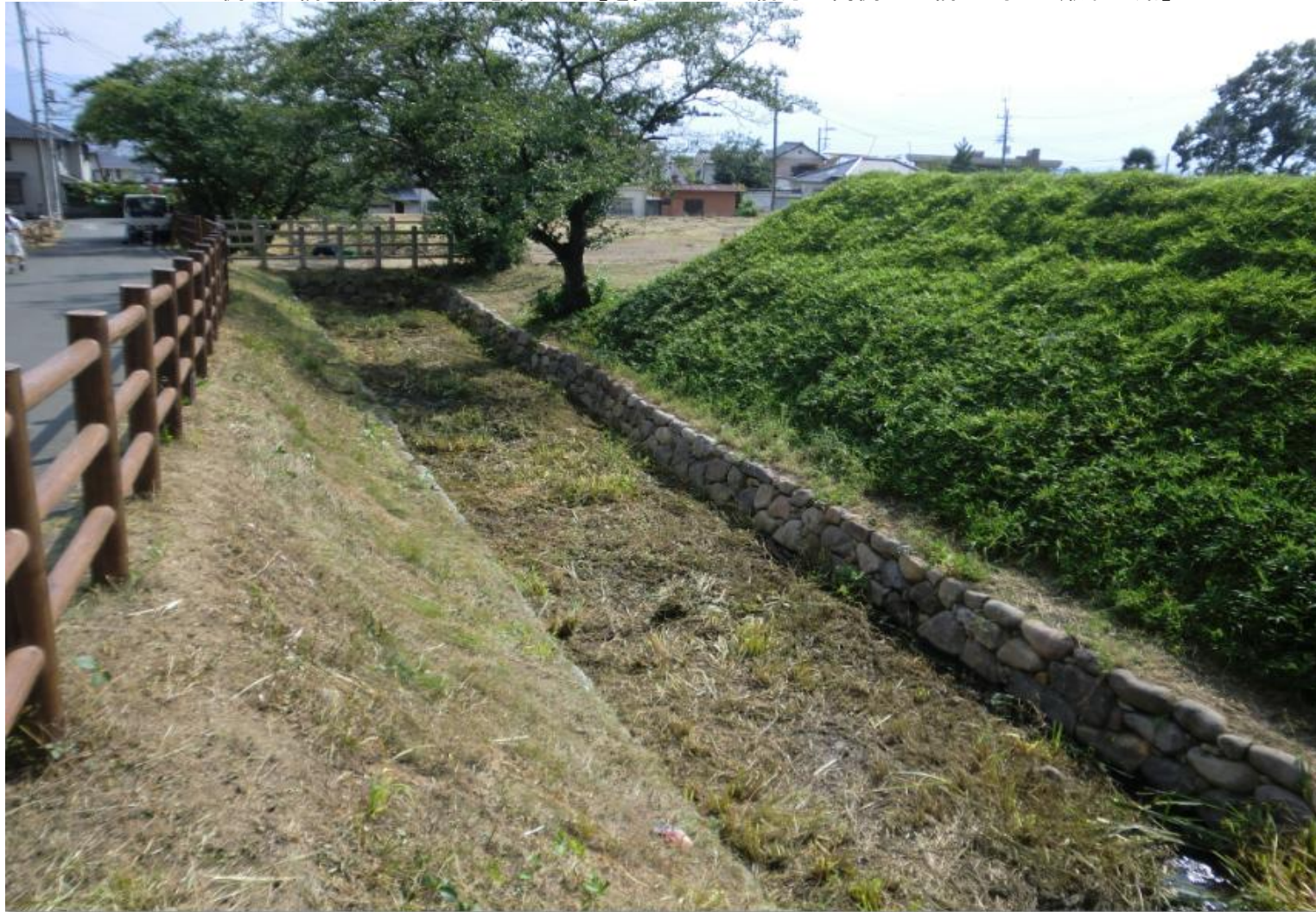
北側の土橋上で南方向に「惣堀・土塁」を見たところ/前方は南側の土橋/左手が「鍛冶小路」
