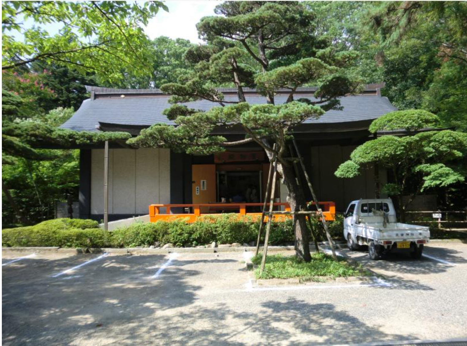
鉄筋コンクリート造
