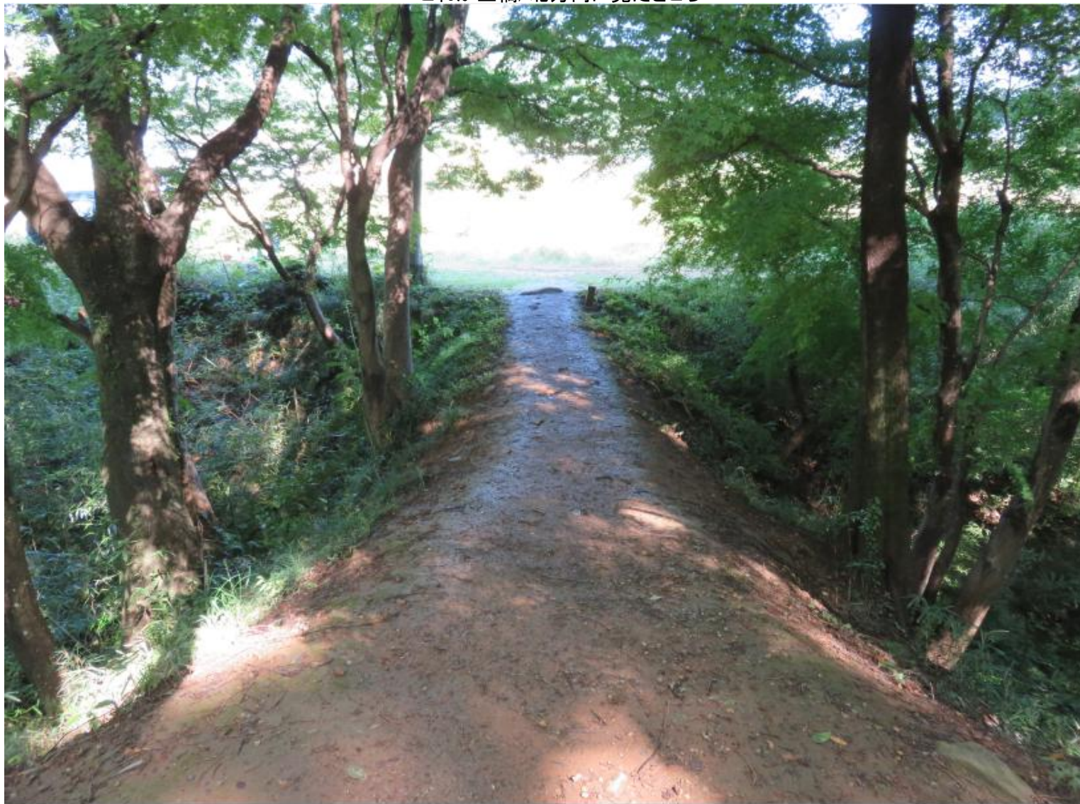
これが土橋/北方向に見たところ
