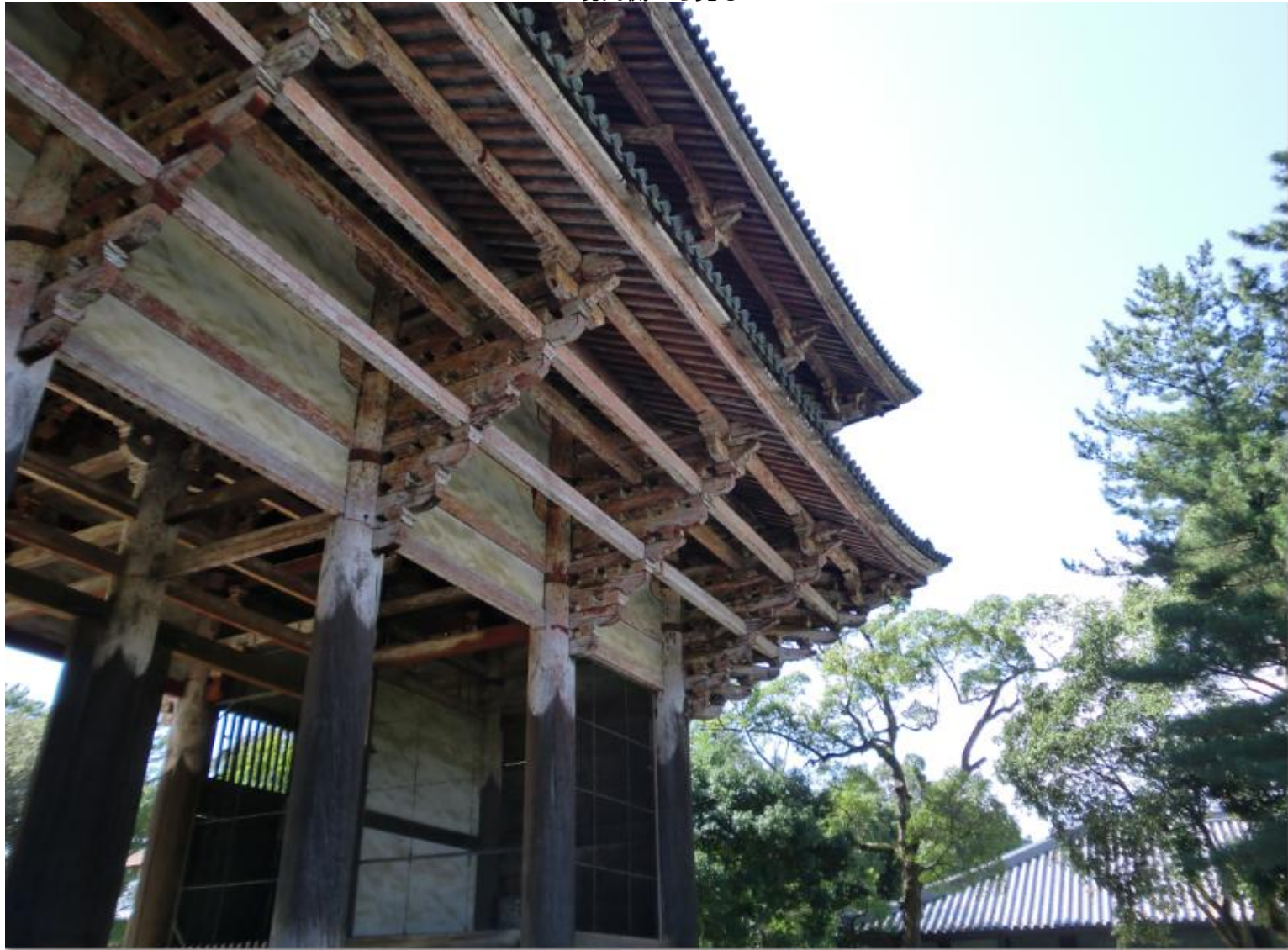
境内側から見る
