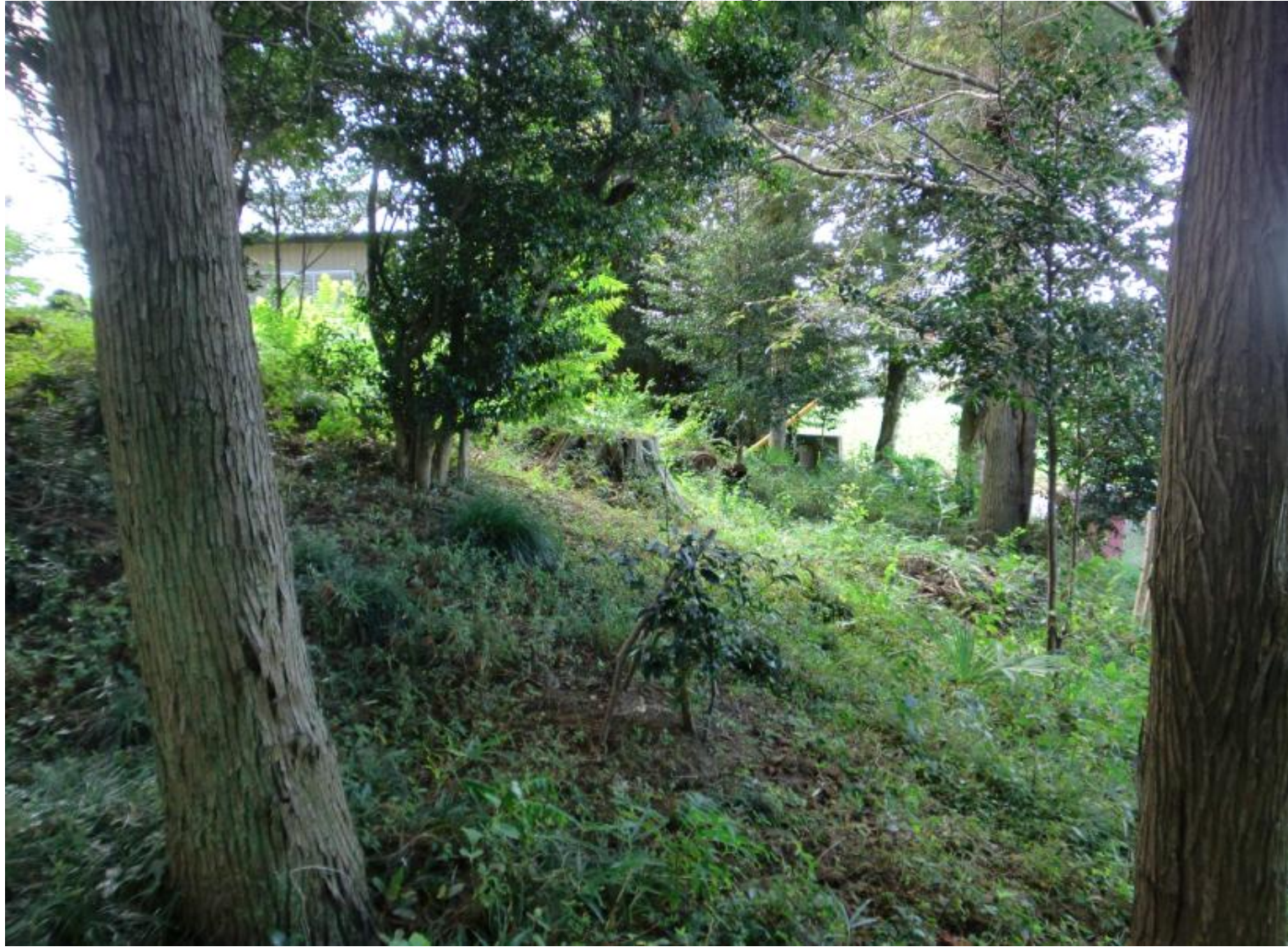
前方部の斜面(法面)を見る
