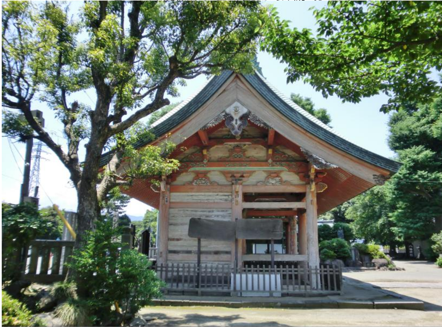
「堂々とした外観を構成する二重虹梁幕股式の妻架構」が見てとれる
