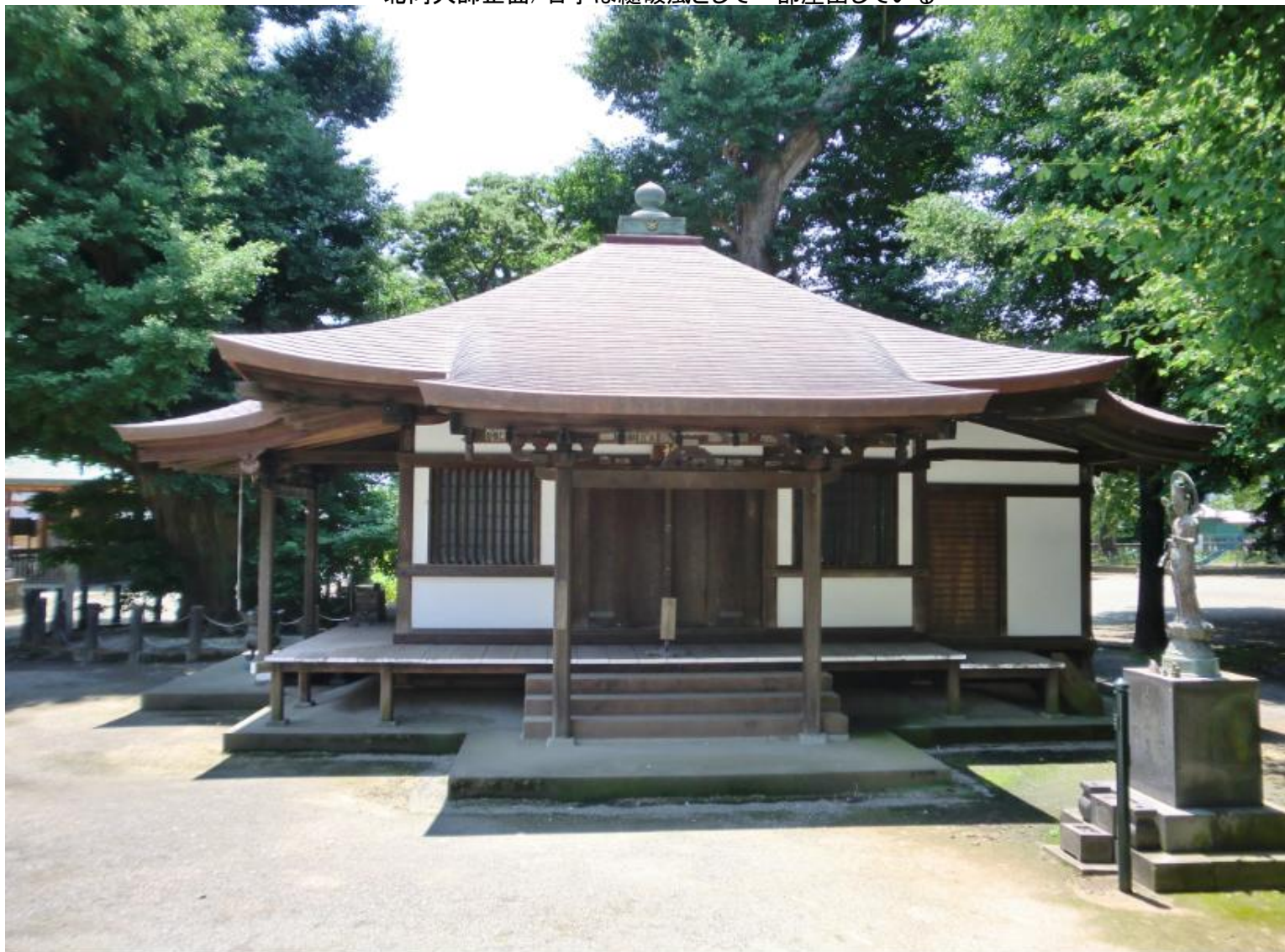
北向大師正面/右手は縫破風として一部屋出している
