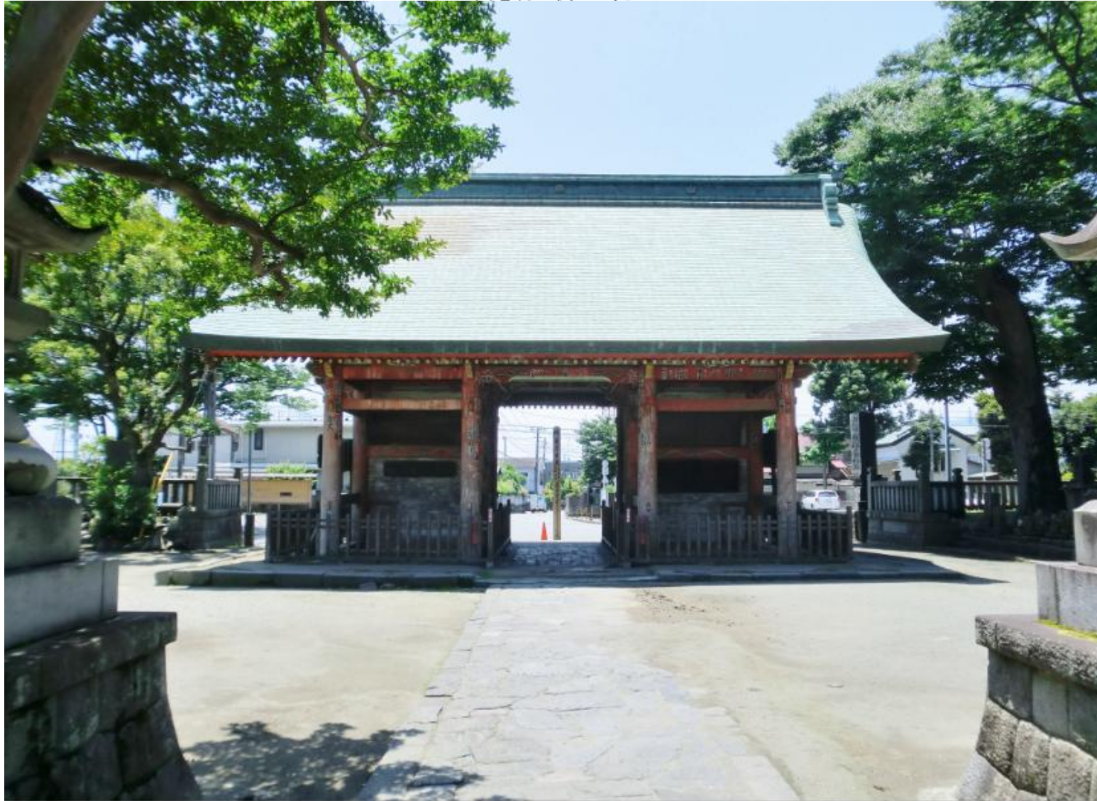
仁王門を境内側から見たところ
