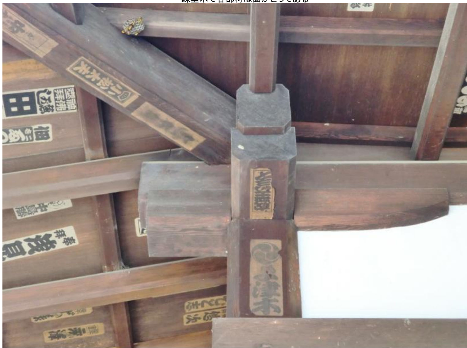
疎垂木で各部材は面がとってある
