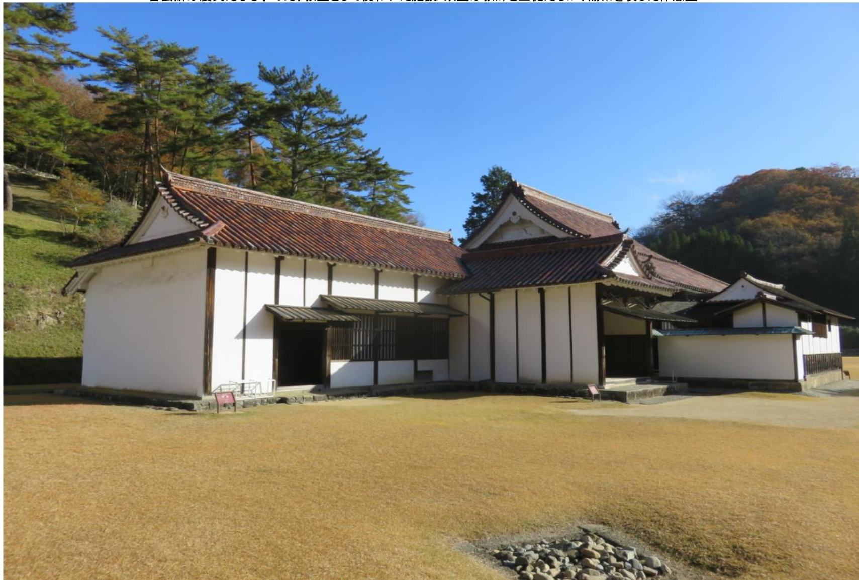
習芸斎は農民たちも学んだ、教室として使われた施設/飲室は教師と生徒たちが、湯茶を喫した休憩室
