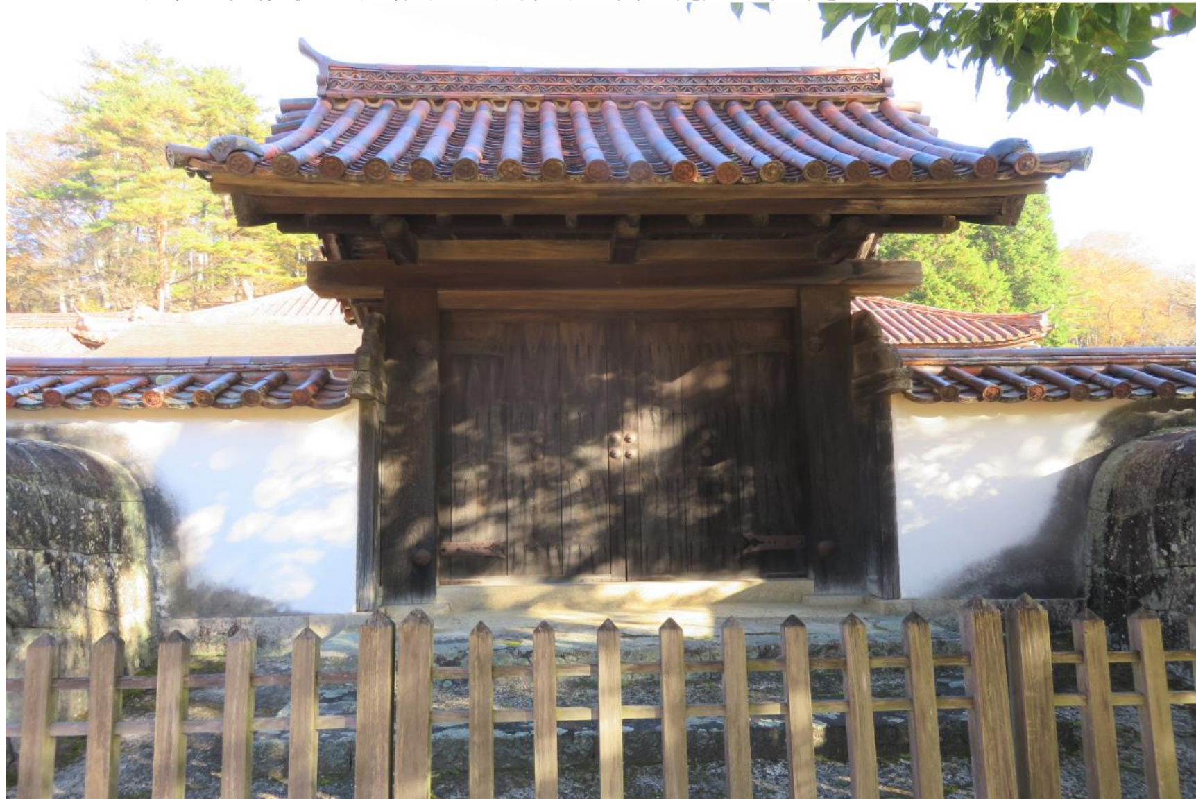
公門/藩主臨学の際に使用した門で御成門とも云う/本柱の後ろに控柱二本を建てて切妻屋根をのせる薬医門様式の建物
