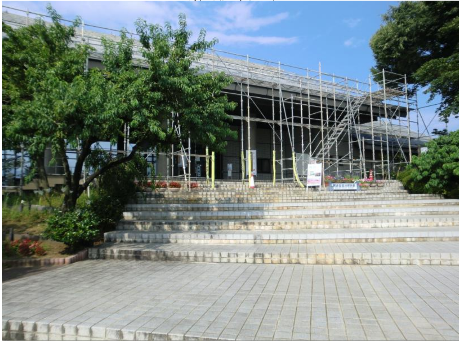
外装の改修工事中のようだ
