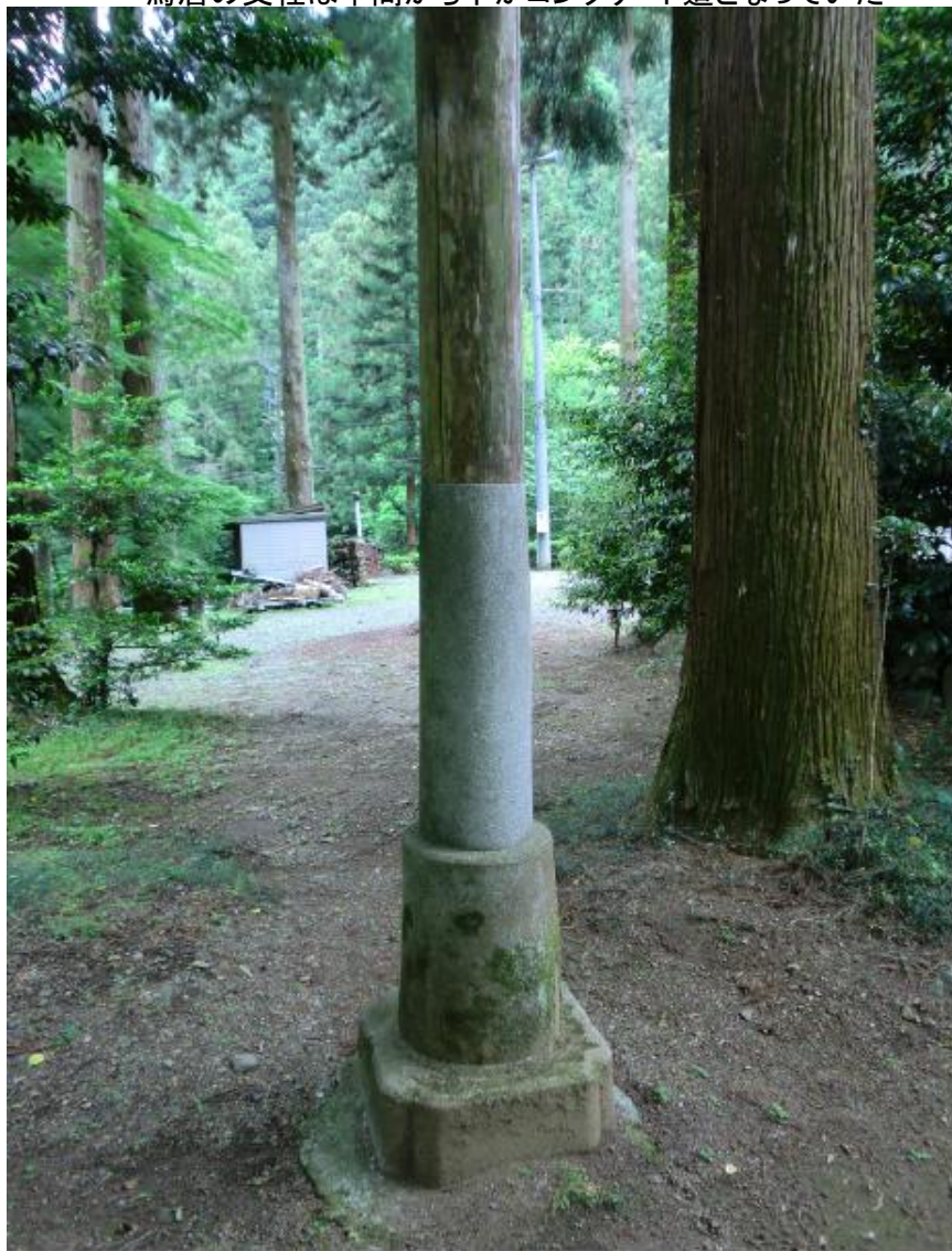
鳥居の支柱は中間から下がコンクリート造となっていた
