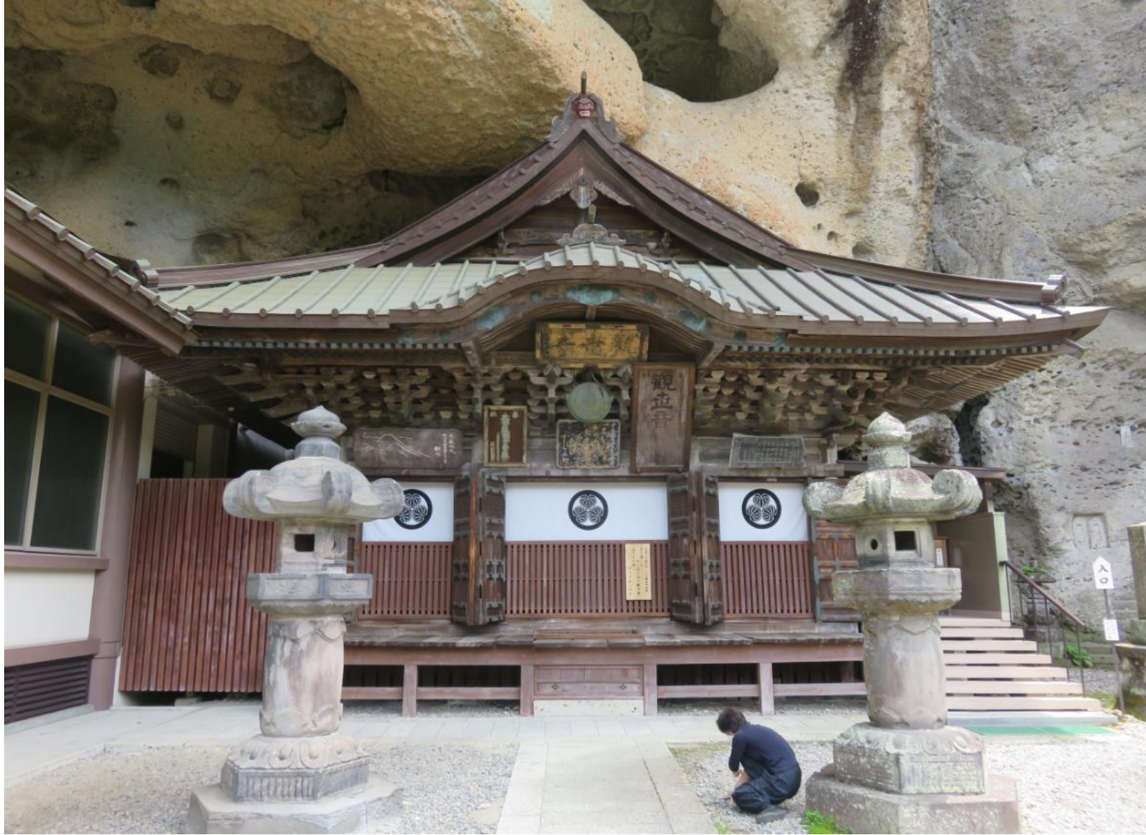
これは観音堂/江戸時代初期に建てられた本堂
