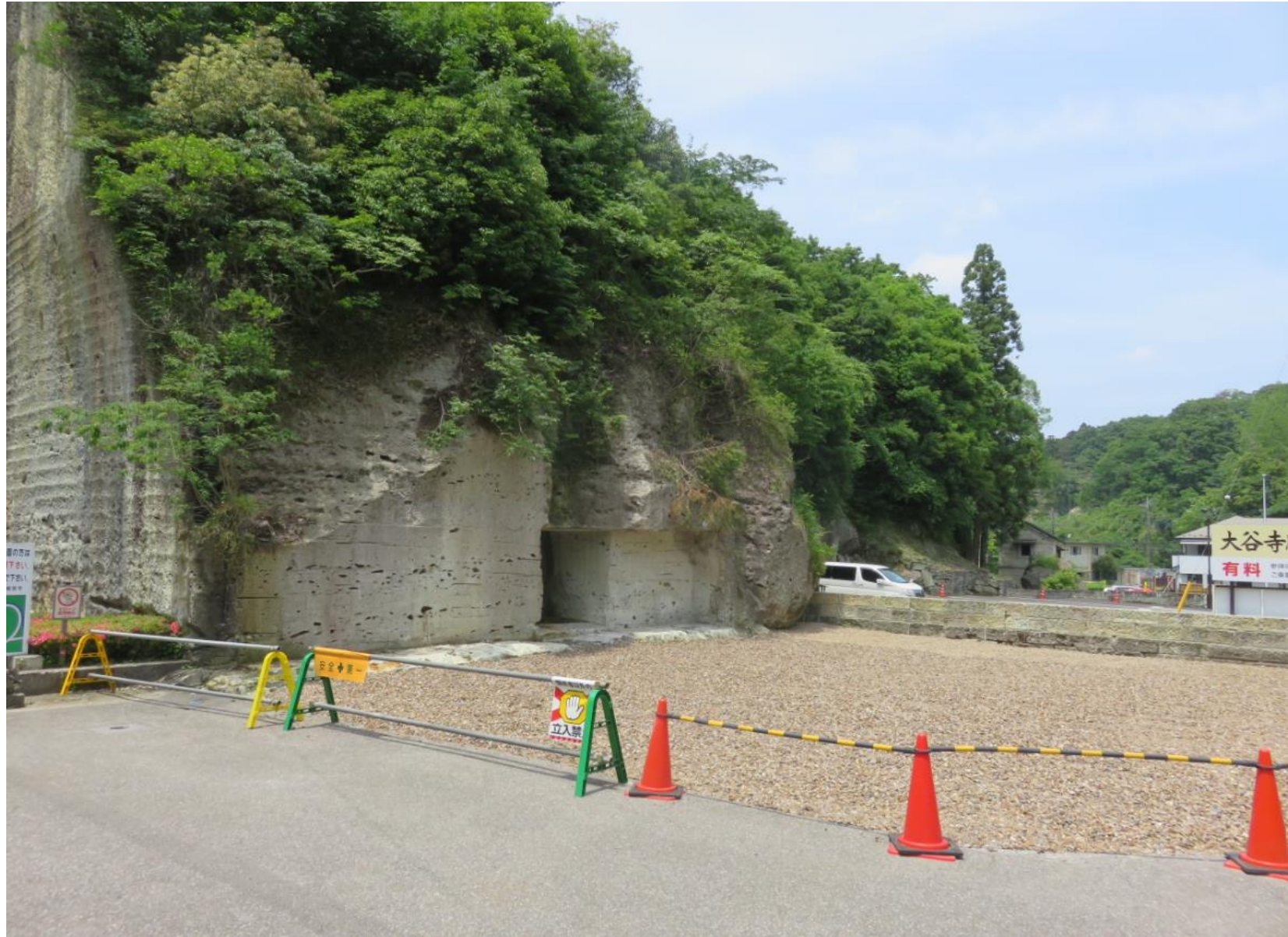
同じく、左手を見たところ/こちら岩肌がそそり立っている
