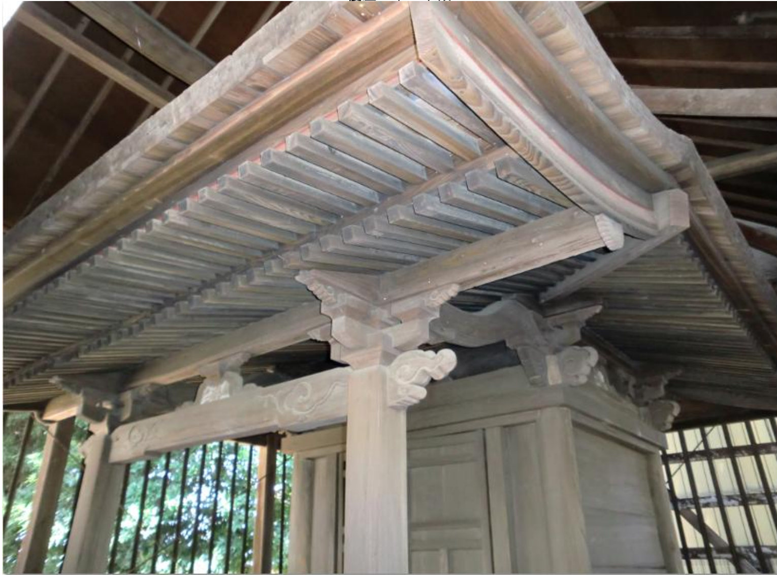
覆屋の中の本殿
