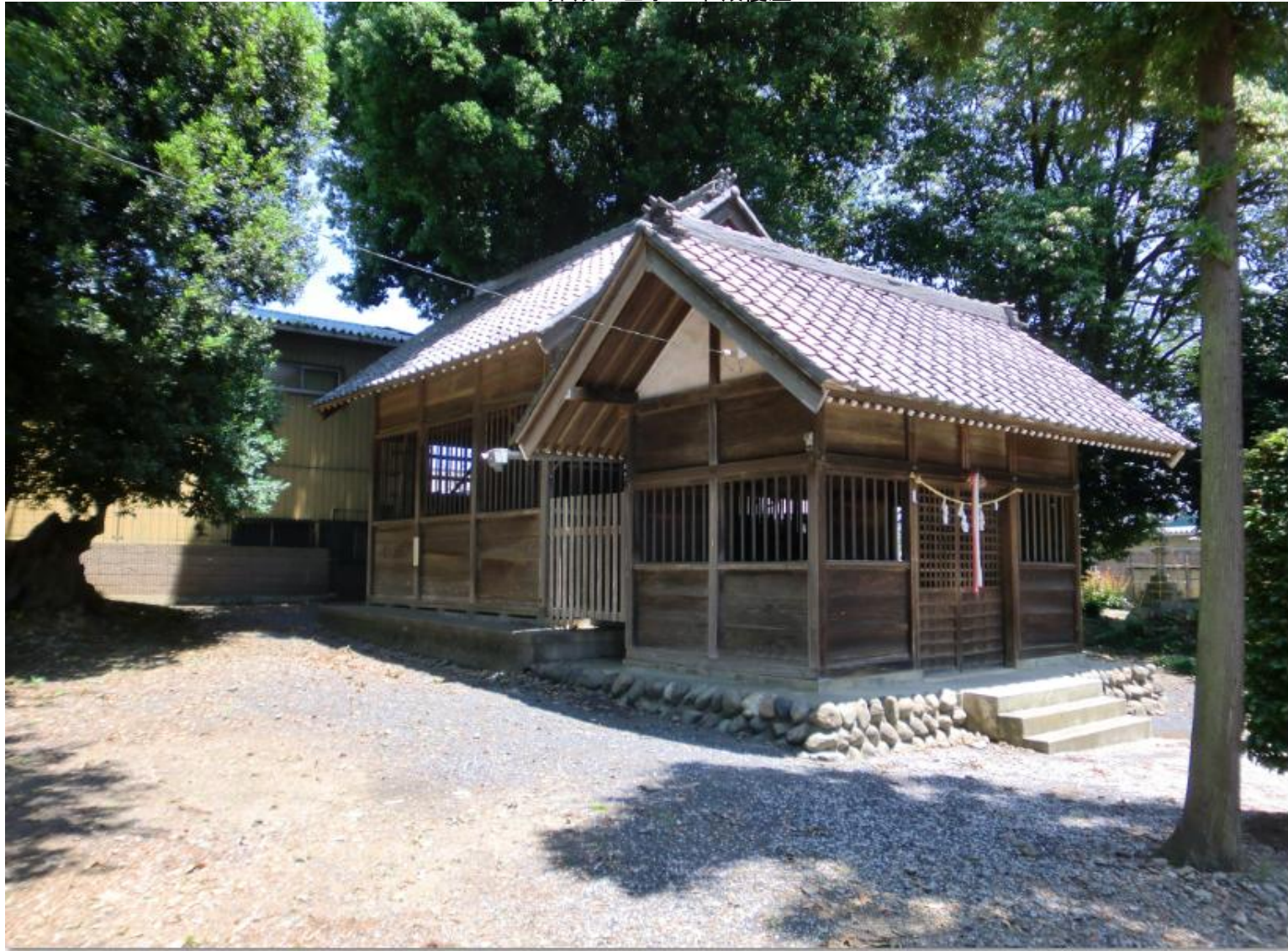
拝殿の左手が本殿覆屋
