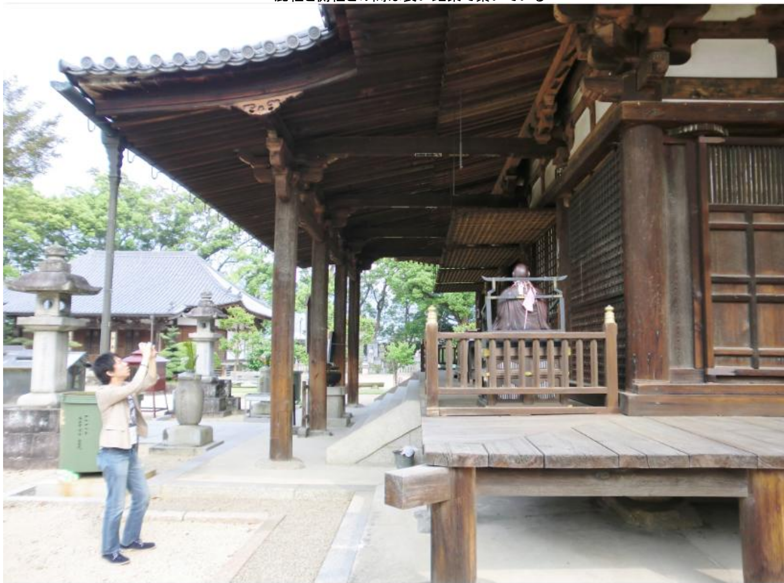
庇柱と側柱との間は長い虹梁で繋いでいる
