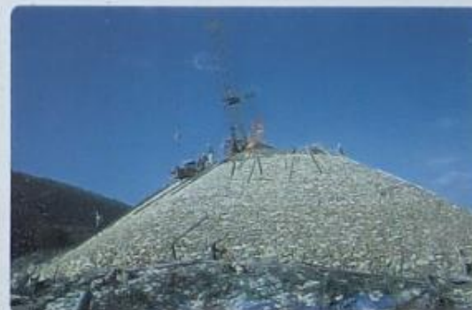
復原工事 クレーンやトラックなどの機械が 使われました。 (1日約10人で約300日)
