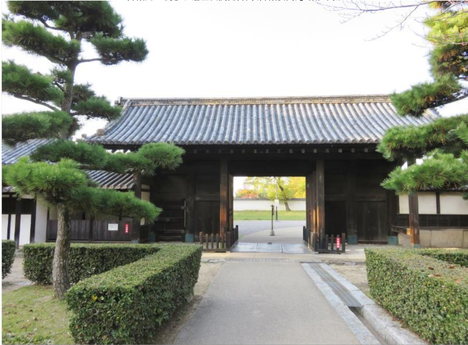
御殿内から見た「藩主玄関先御門(御殿表門)」/葉医門形式
