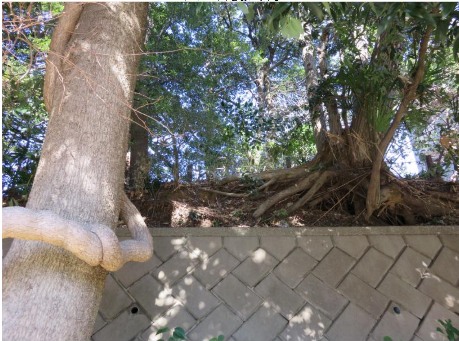
フェンスの中を覗いてみる
