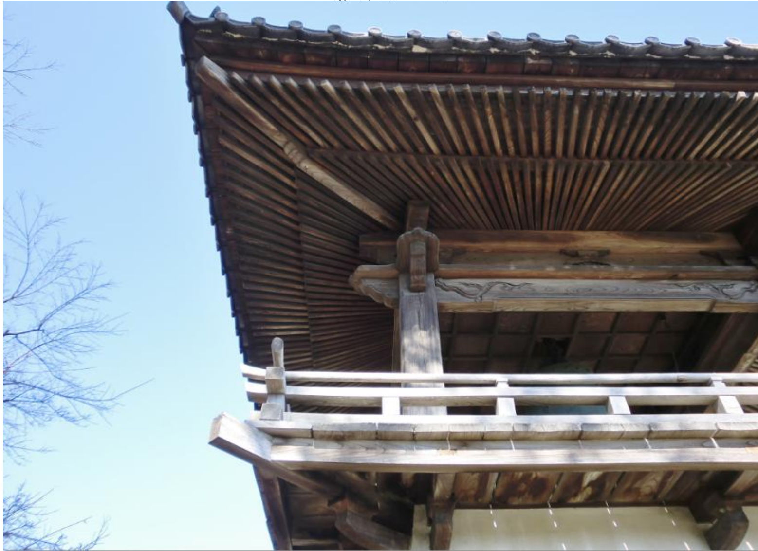
扇垂木となっている
