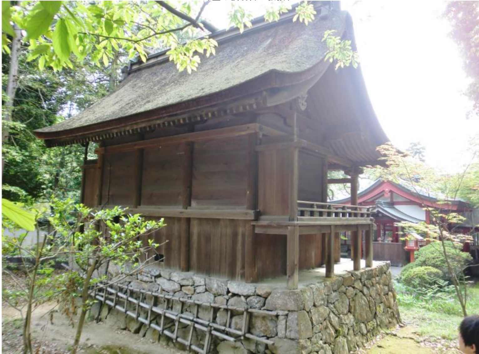
外壁は横羽目の板張り
