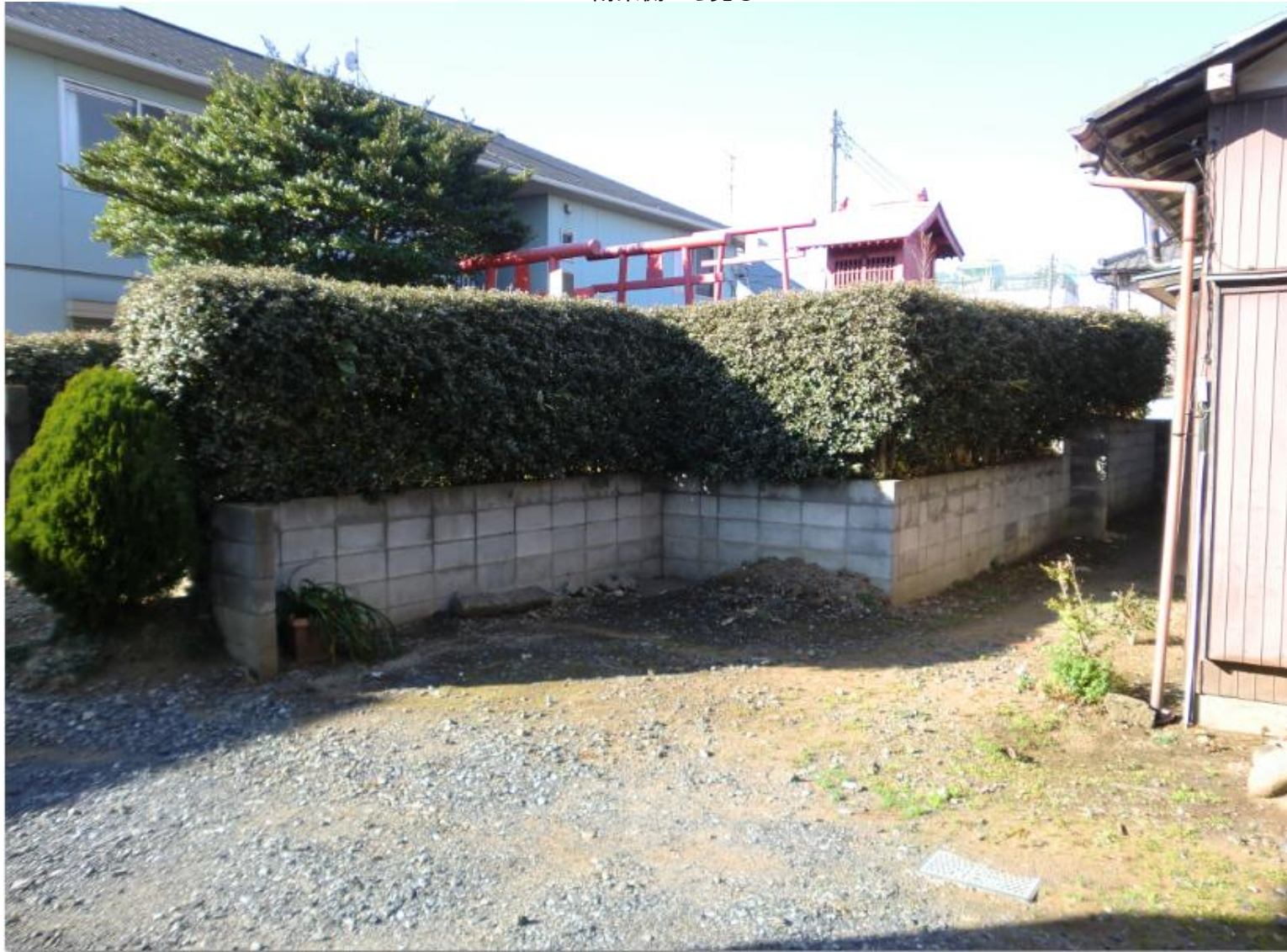
南東側から見る
