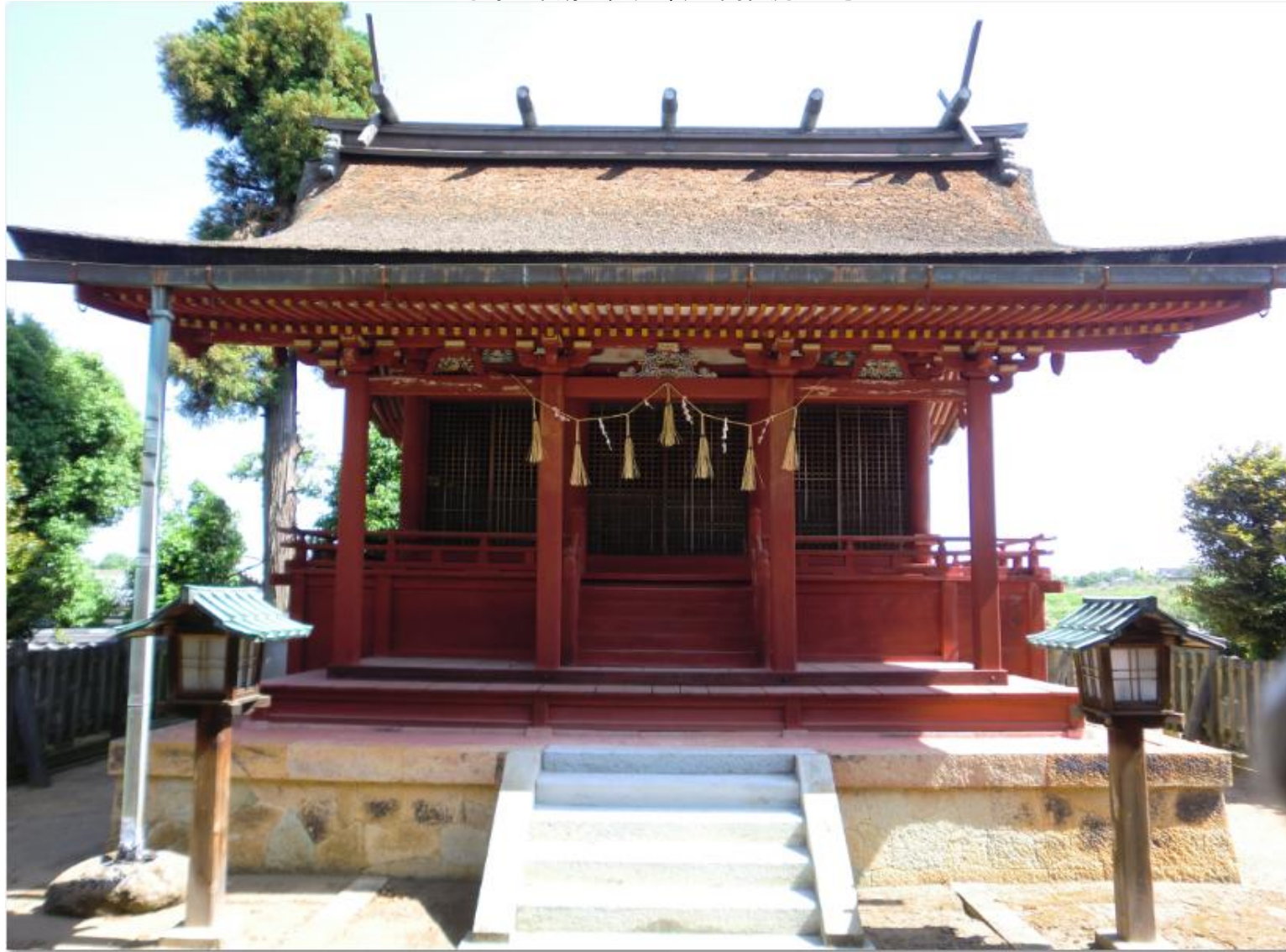
室町時代中期の檜皮葺、三間社流造とされる
