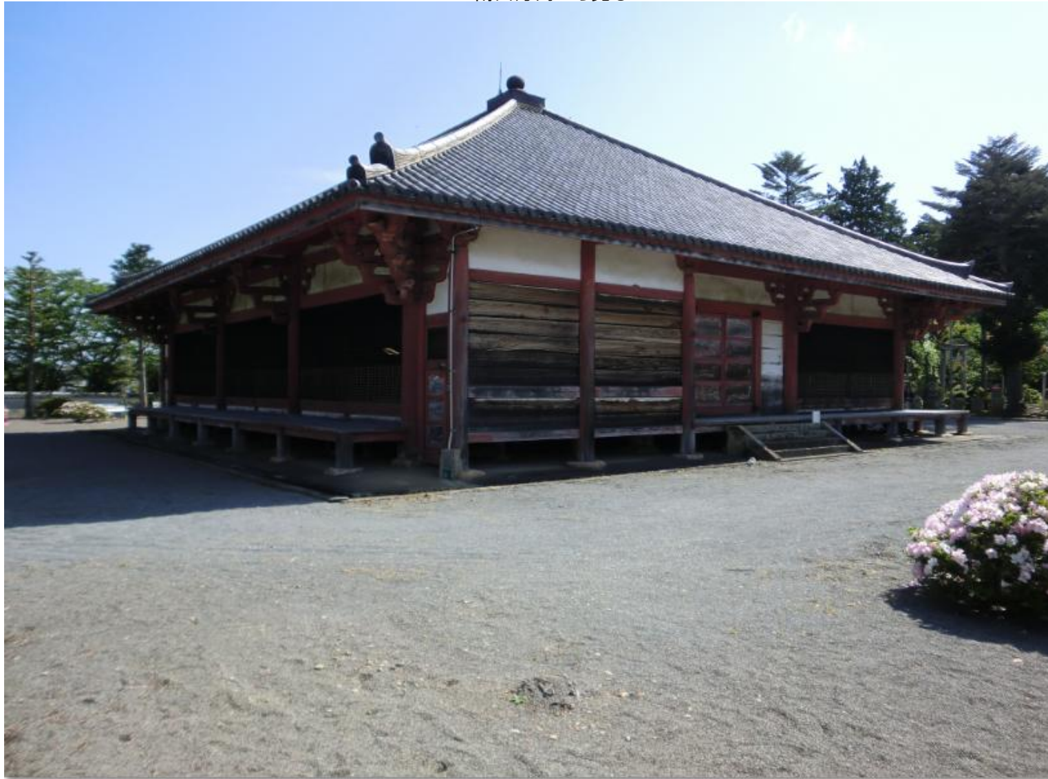
南西方向から見る
