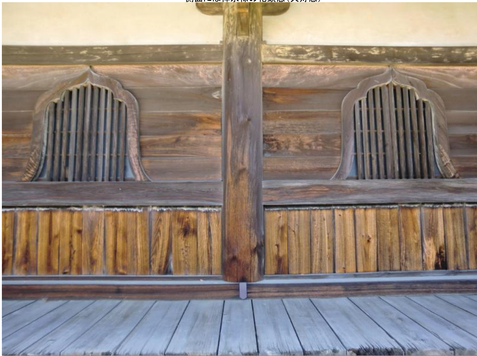
側面には禅宗様の花頭窓(火灯窓)
