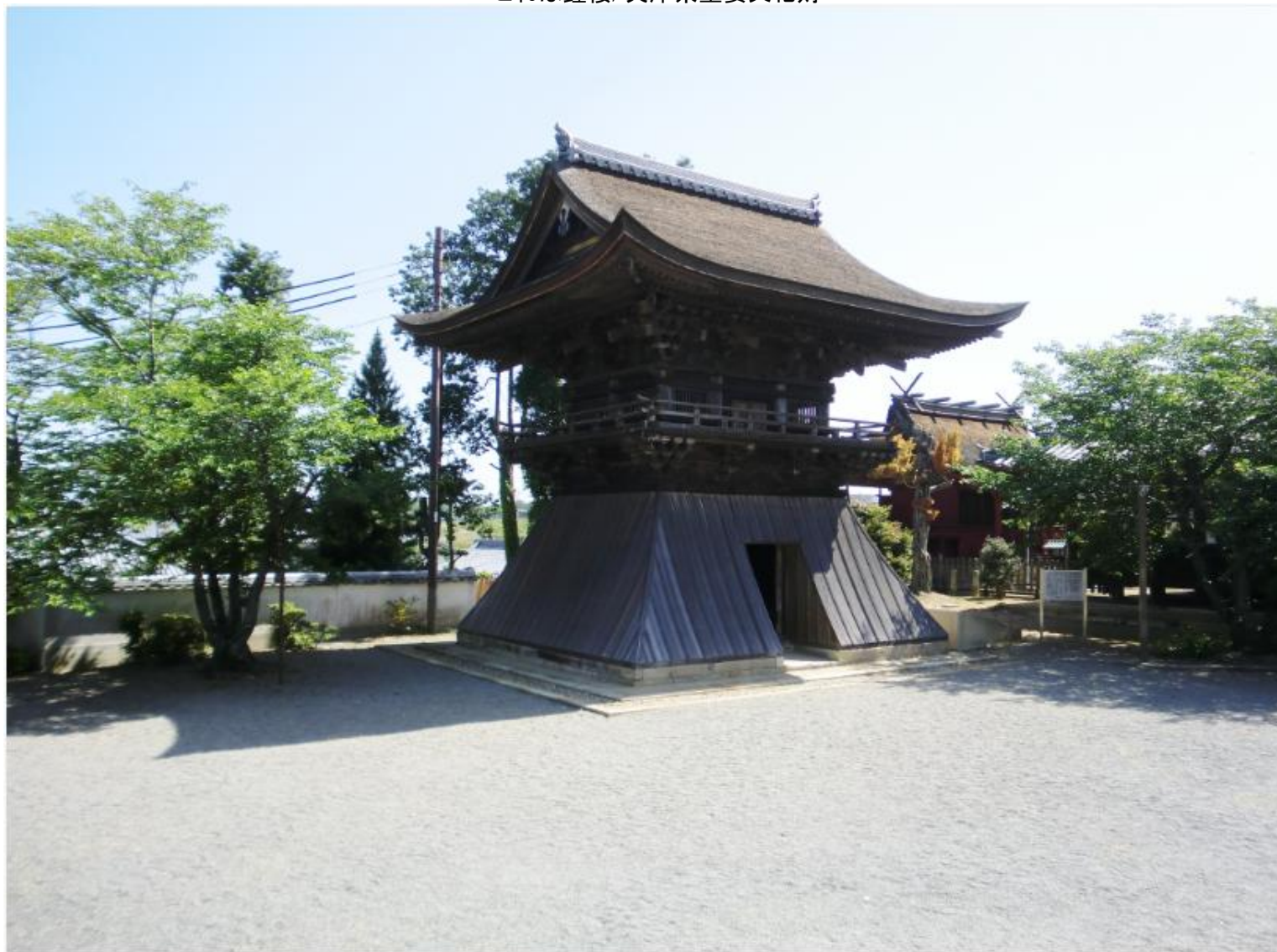
これは鐘楼/兵庫県重要文化財
