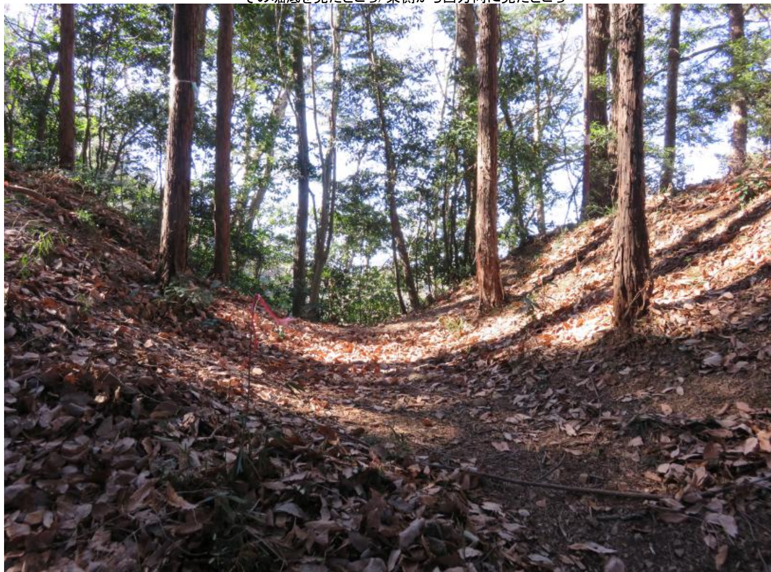
その堀底を見たところ/東側から西方向に見たところ
