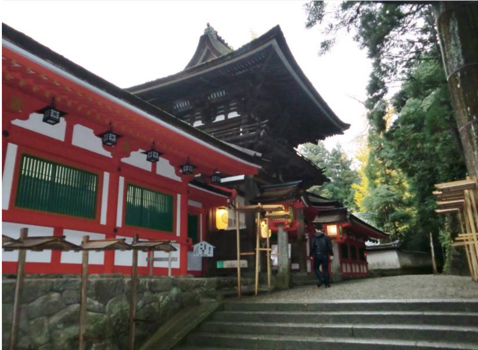
西廻廊(左手前)、楼門、東廻廊(右奥)を見たところ
