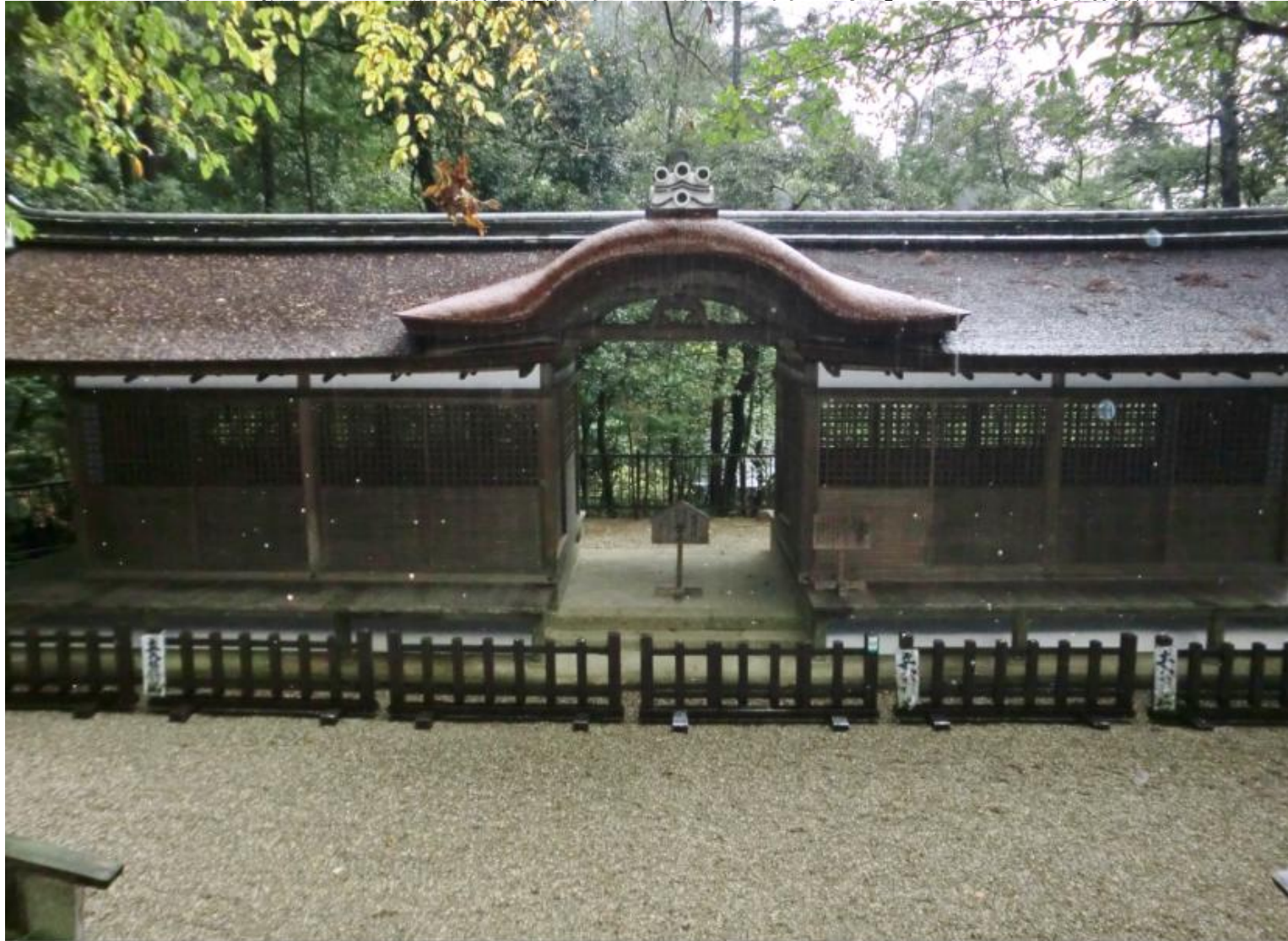
そこから振り返ると出雲建雄神社拝殿が見える/中央に一間の「馬道」と呼ぶ通路を開く割拝殿形式
