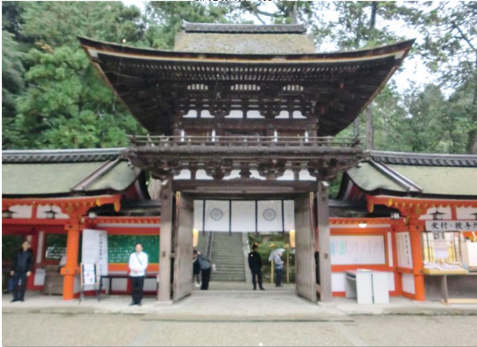
楼門を境内側から見たところ
