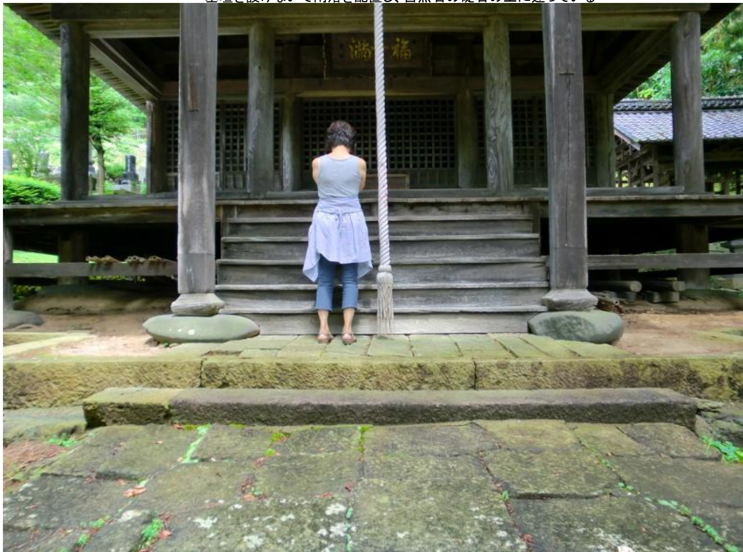
基壇を設けなくて雨落を配置し、自然石の礎石の上に建っている
