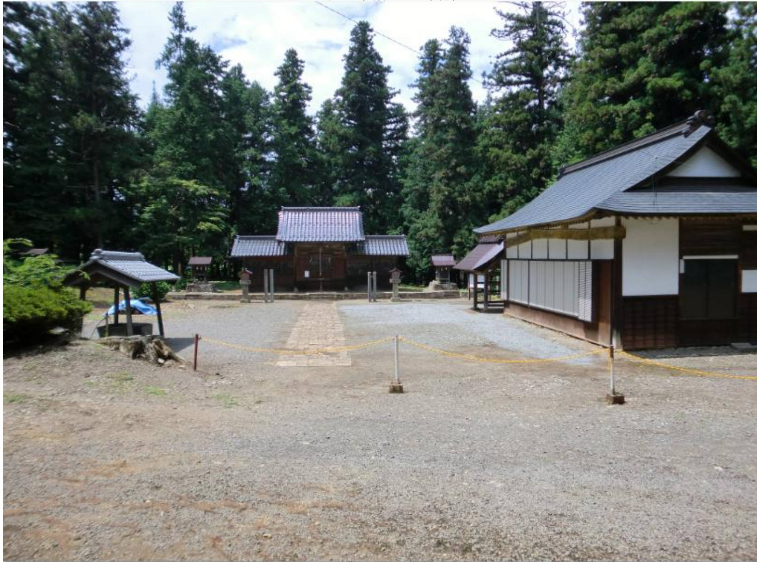
正面は本殿/1714年再建
