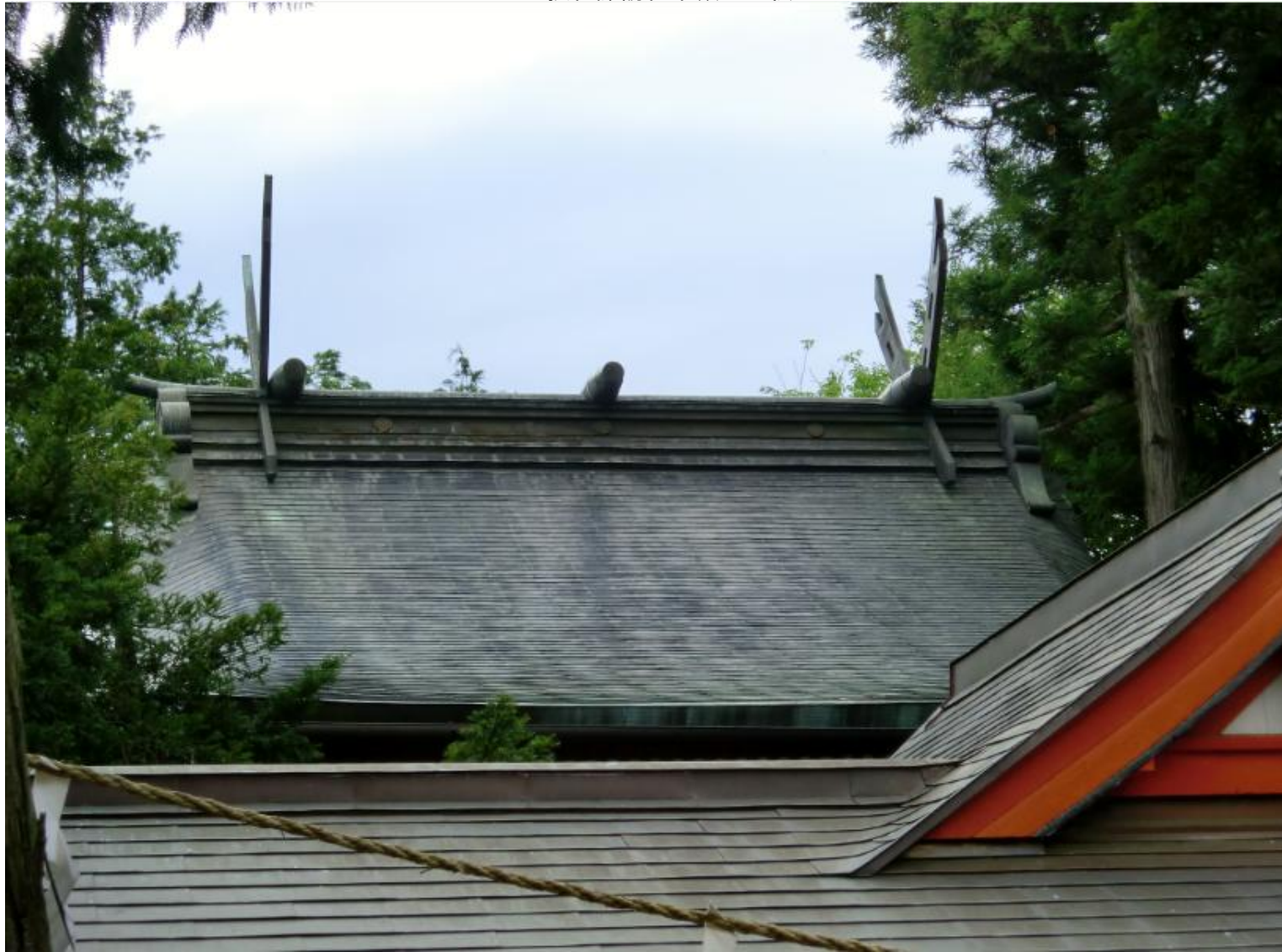
摂社諏訪社本殿の屋根
