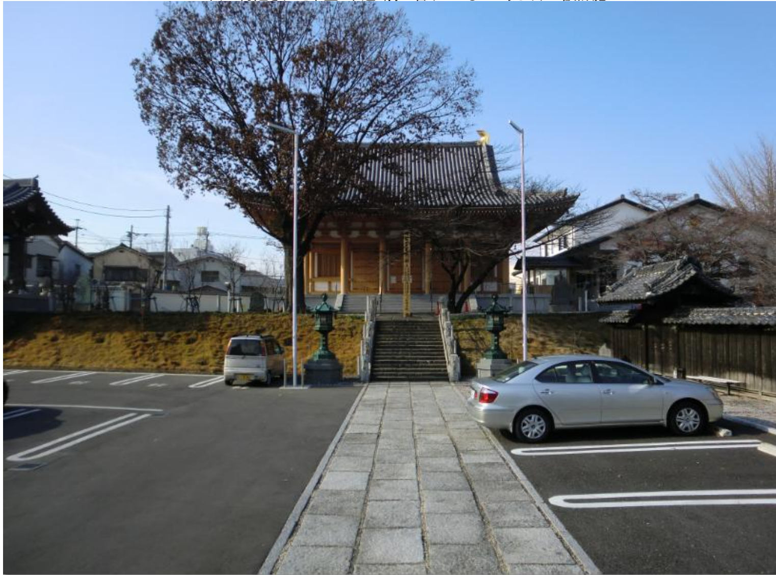
正面が再建された本堂/木造/鶺鴒工舎(いかるがこうしゃ)の設計施工
