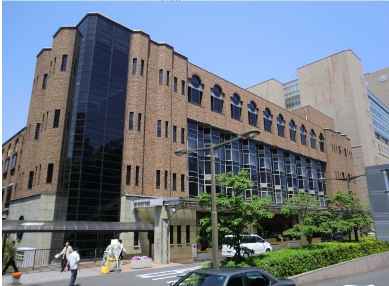
外来診療棟のエントランスのファサード
