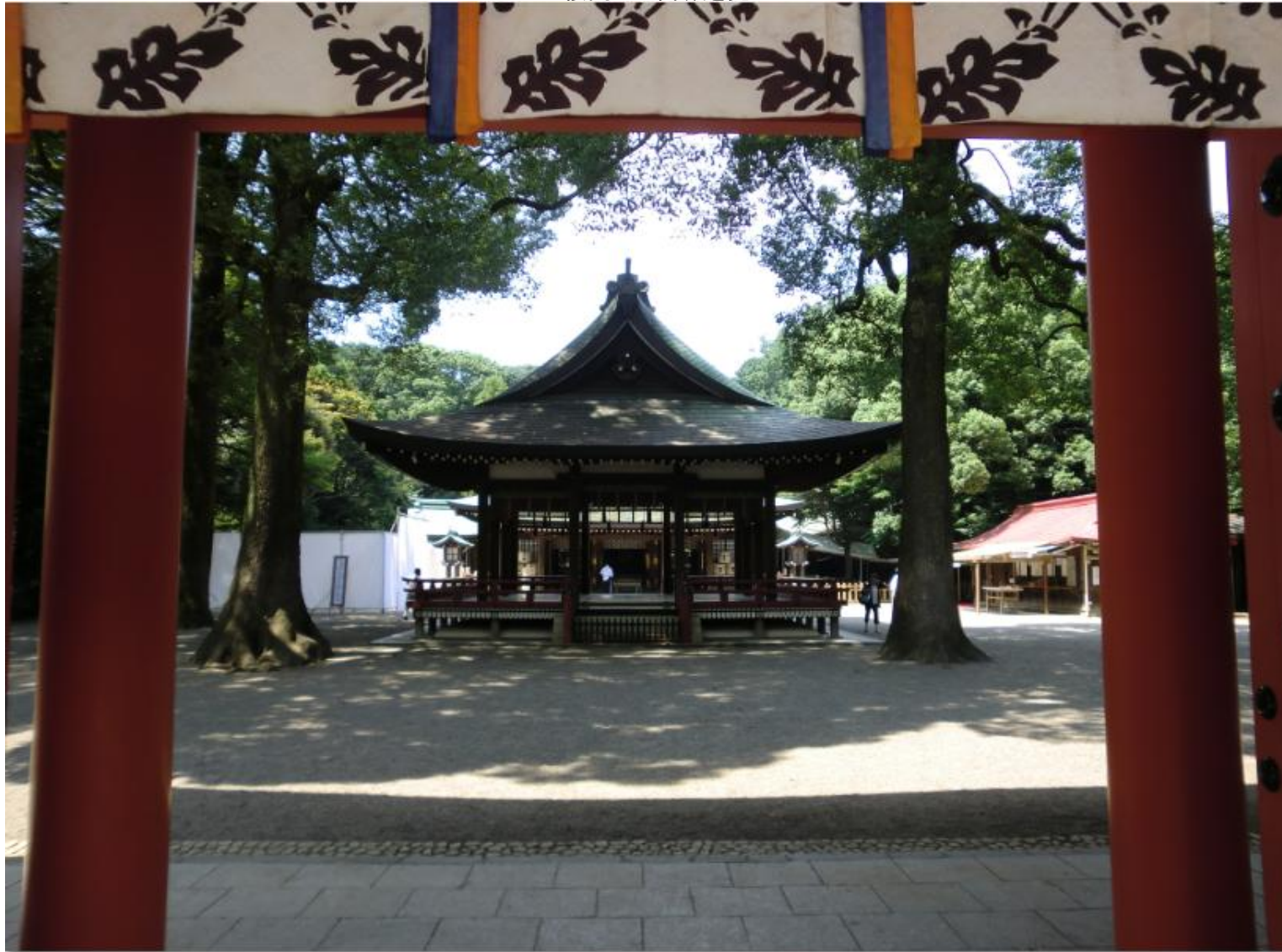
楼門から舞殿を見る
