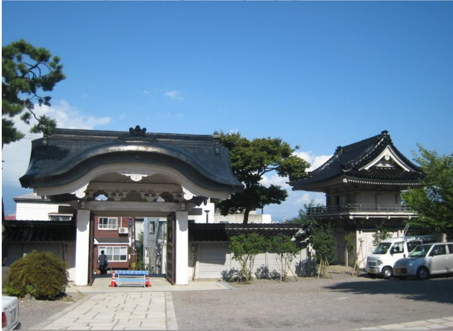
境内から見た正門(左手)と鐘楼(右手)/共に重要文化財/鉄筋コンクリート造/大正5年竣工
