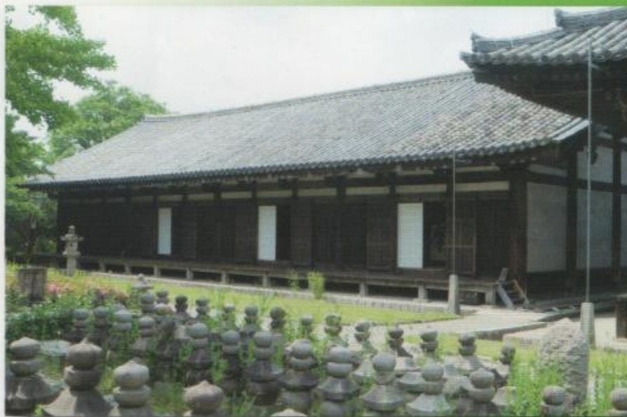
禅室外観 現在は 4 室分が残存している。
