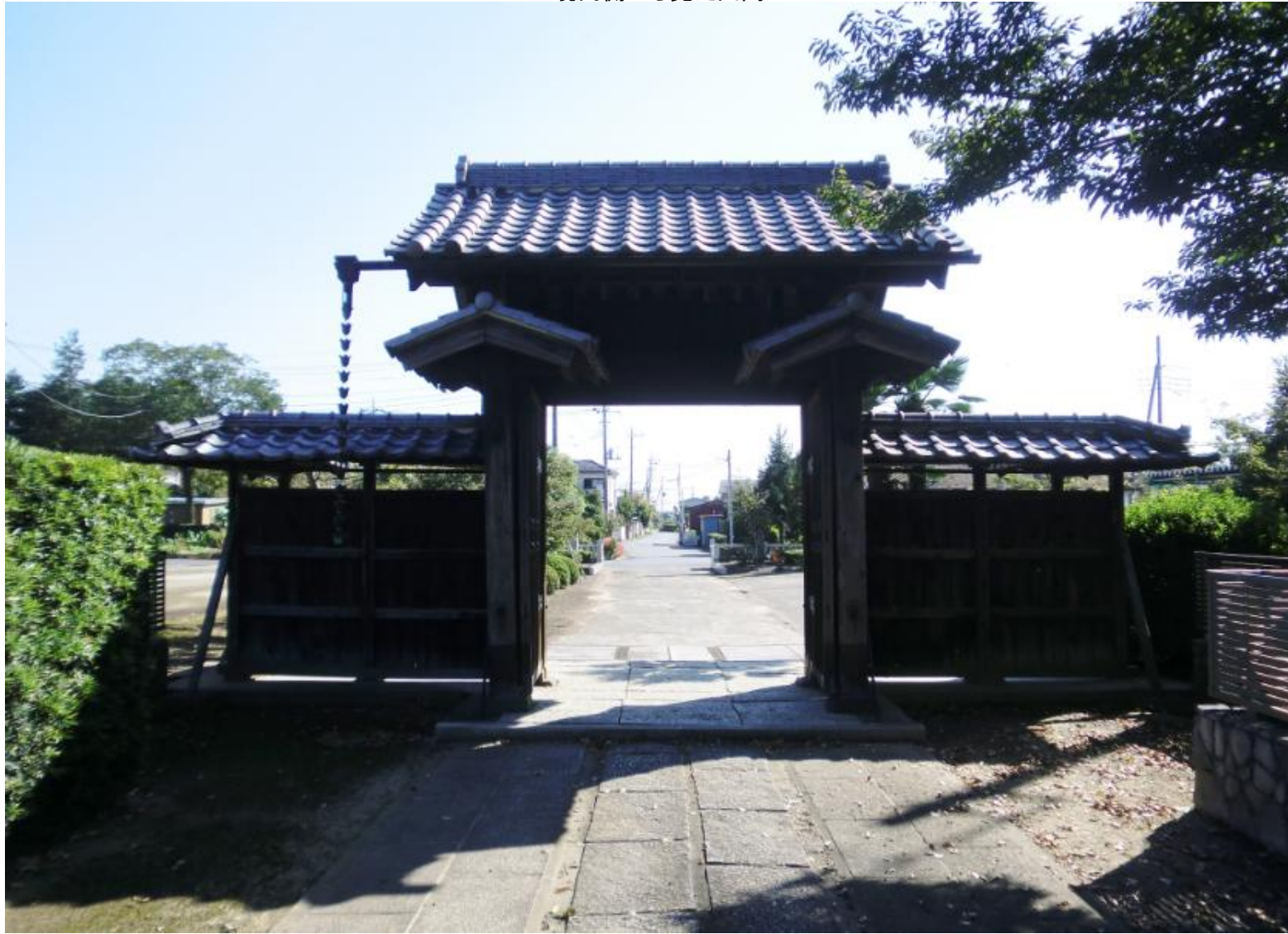
境内側から見た山門
