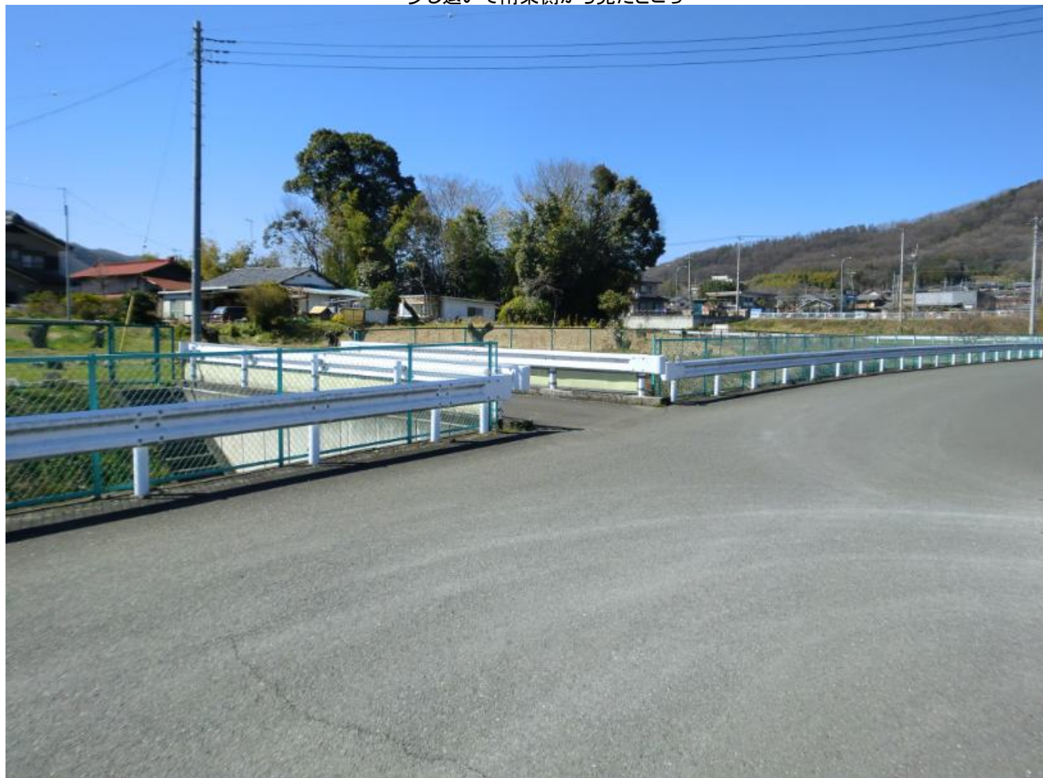
少し退いて南東側から見たところ
