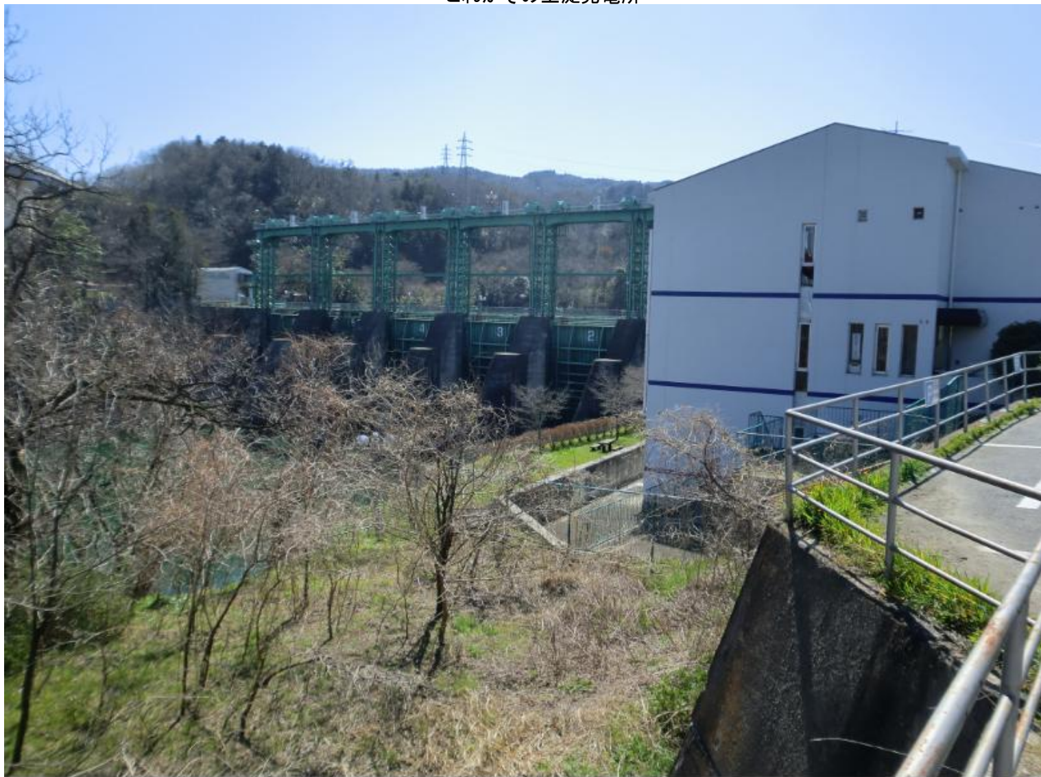
これがその玉淀発電所
