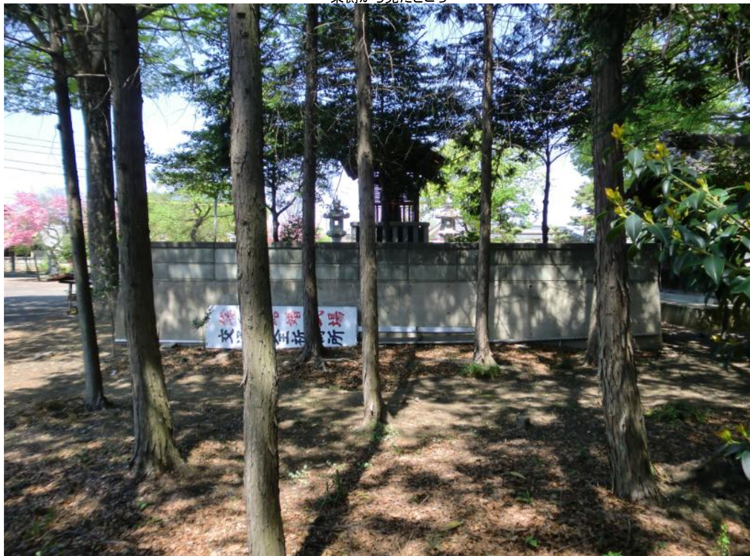
東側から見たところ
