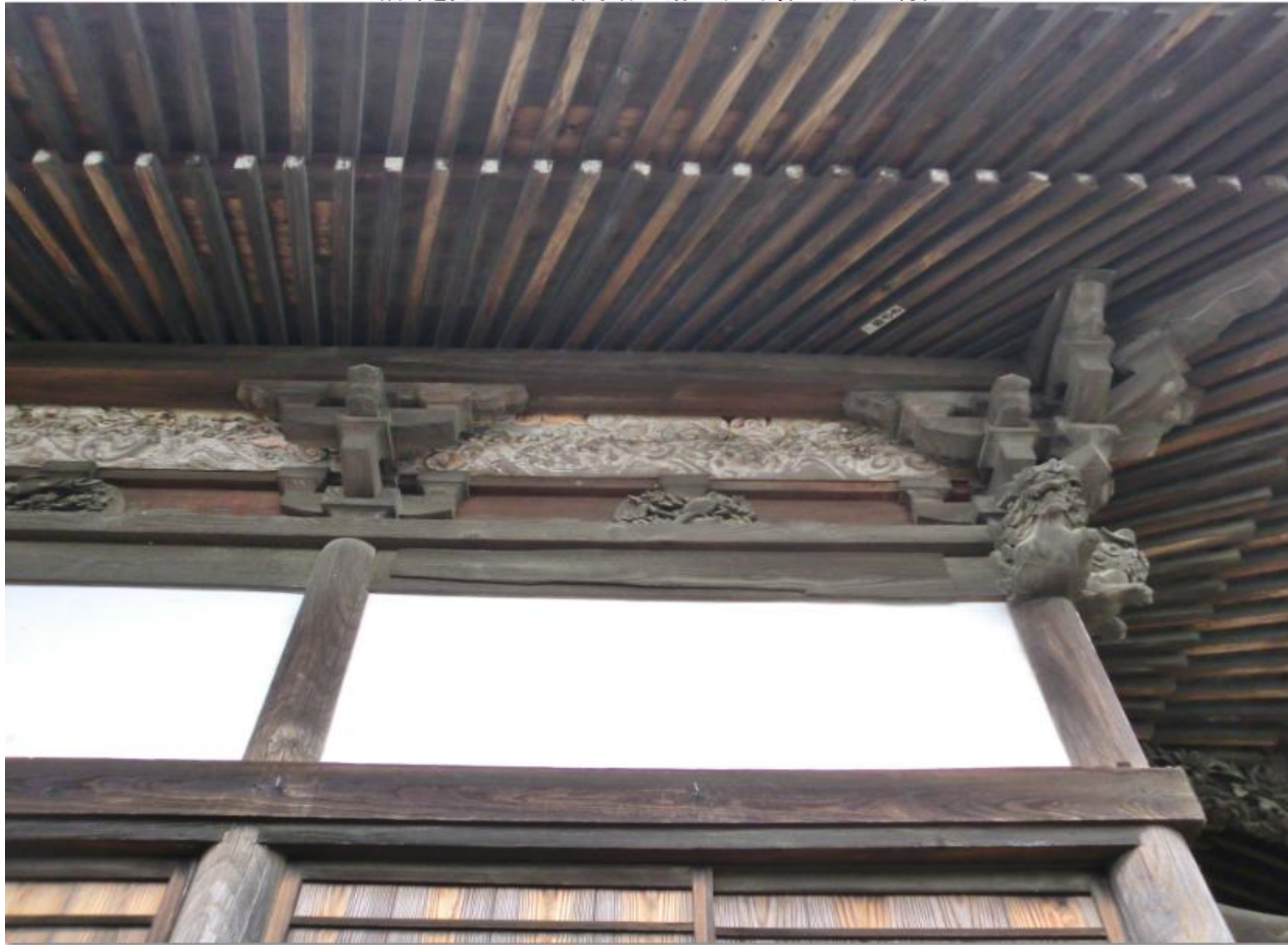
隅部を見たところ/禅宗様の扇垂木/木鼻は近世の雰囲気
