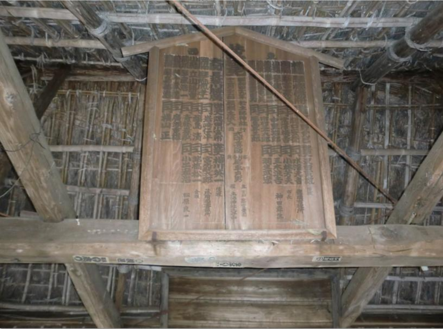
割拝殿の天井を見る
