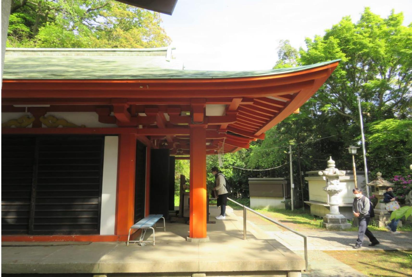
斗拱は大斗形式の一手先で丸桁を受けている/大斗には括れがあるのだが、RC造の場合は木造と違って柱の構造断面が括れの部分で決まり、強度を確保するには不経済でも柱の断面を大きくしなければならない/そうすると他の部材とのバランスを整えることができないため、ここでは柱は大面取りとして、他の部材とのバランスの違和感を救っている/中備は間斗東に雲型の鰭が付く変わったデザインとなっている
