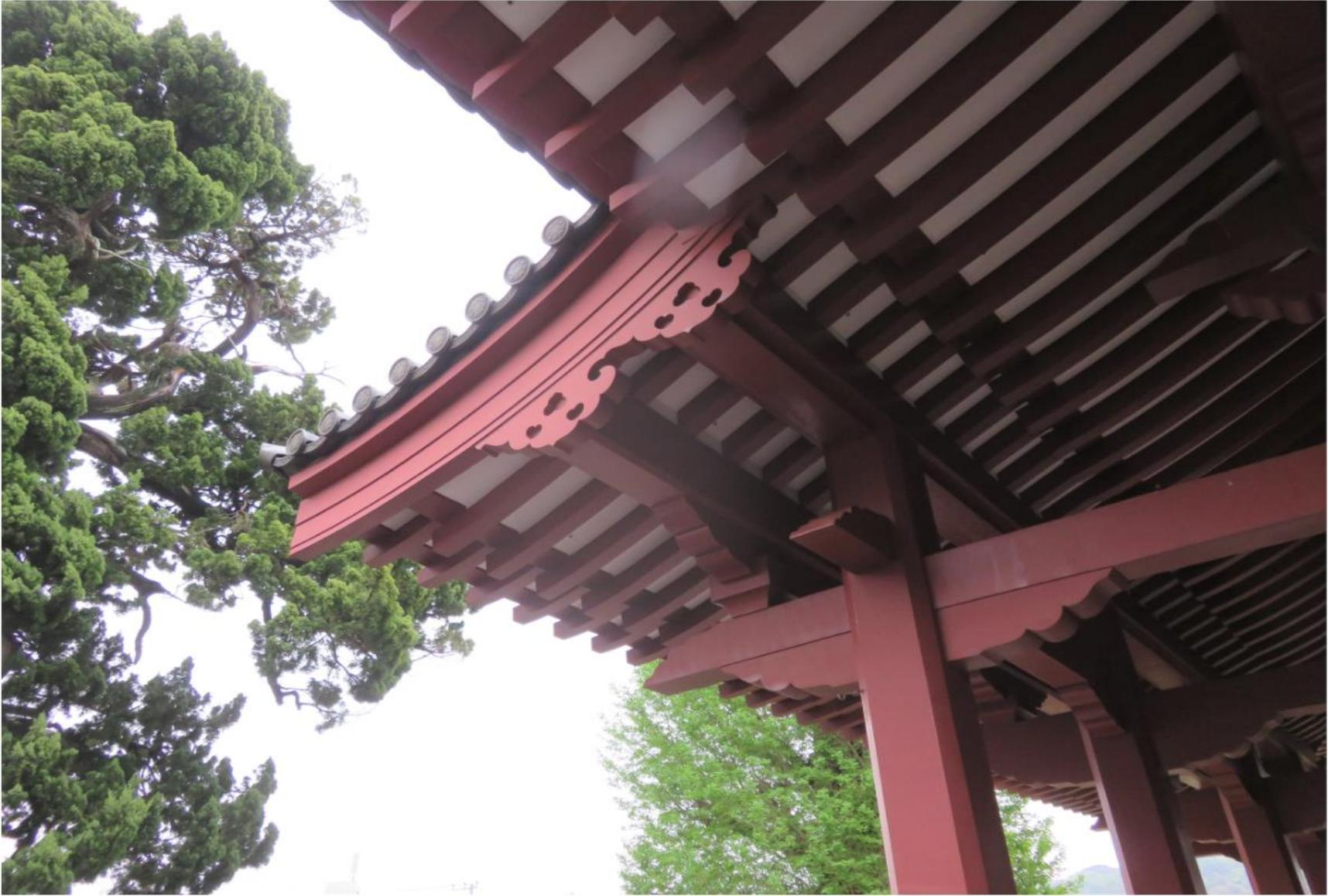
大岡寛独特の挿肘木の手法を用い、これを持送風に取り扱って軒を支え、随所に簡単な繰形を整えている/尾垂木を斜めにせず水平に扱って変化ある形を演出している
