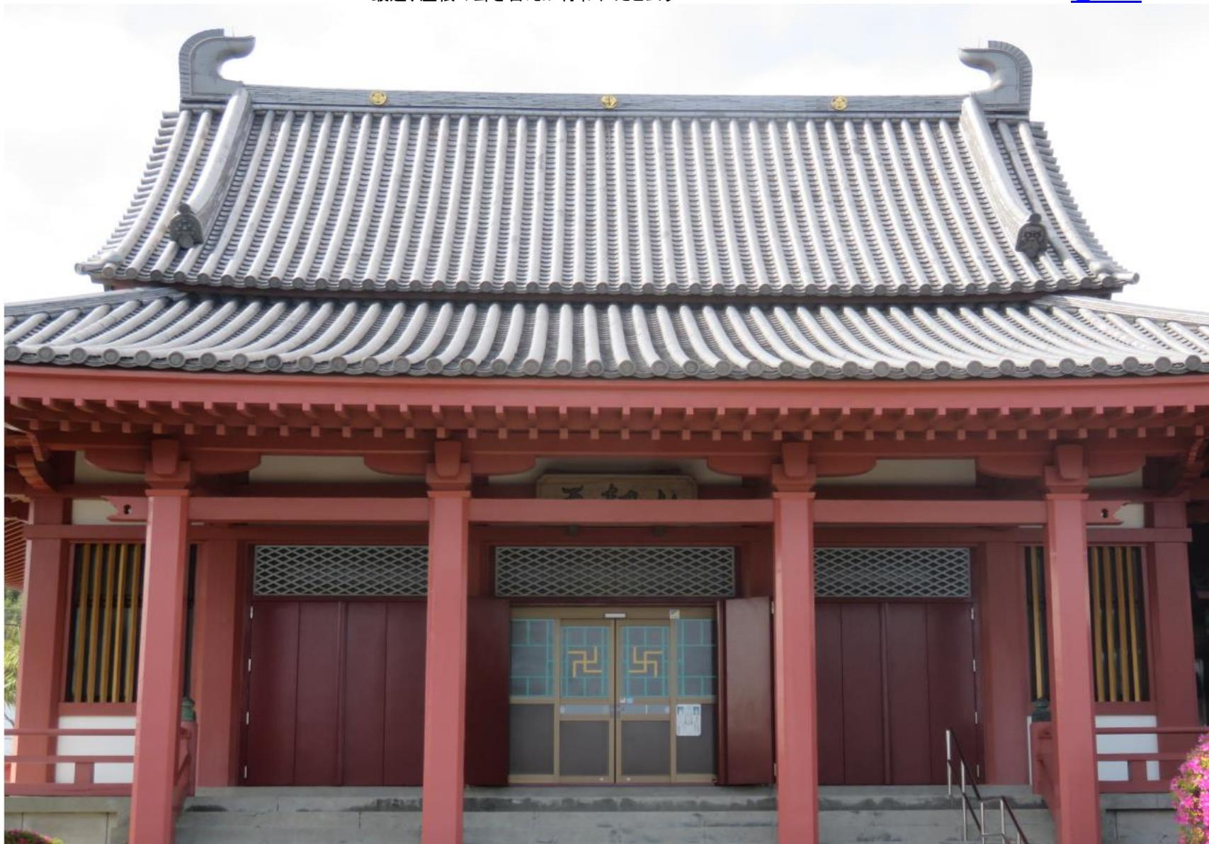
大岡實は「鍔葺の場合、上方の部分は矩勾配(45°)に近く下方の部分は四寸～五寸の緩い勾配で、その結果は上方の屋根は屹立性が強く鋭い感じを持っているが周囲の勾配の緩い屋根がこれを受けて安定感を与えるのに役立っているのであって、極めて巧みな意匠である」と述べている
