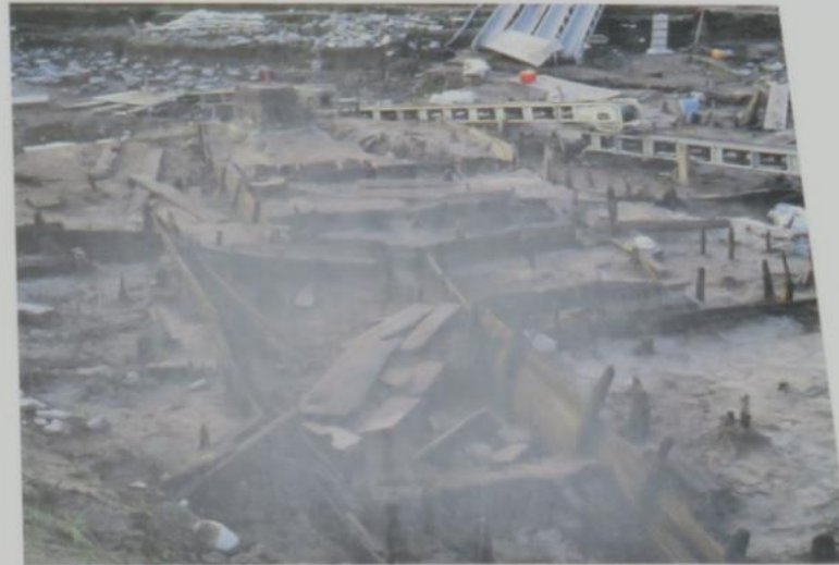
③ 砂が溝に流れ込むのを防ぐ土留め (県道7区) ▲▶ (下は模式図)
