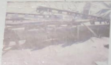
② 横長の板と杭による護岸 (上は模式図)
