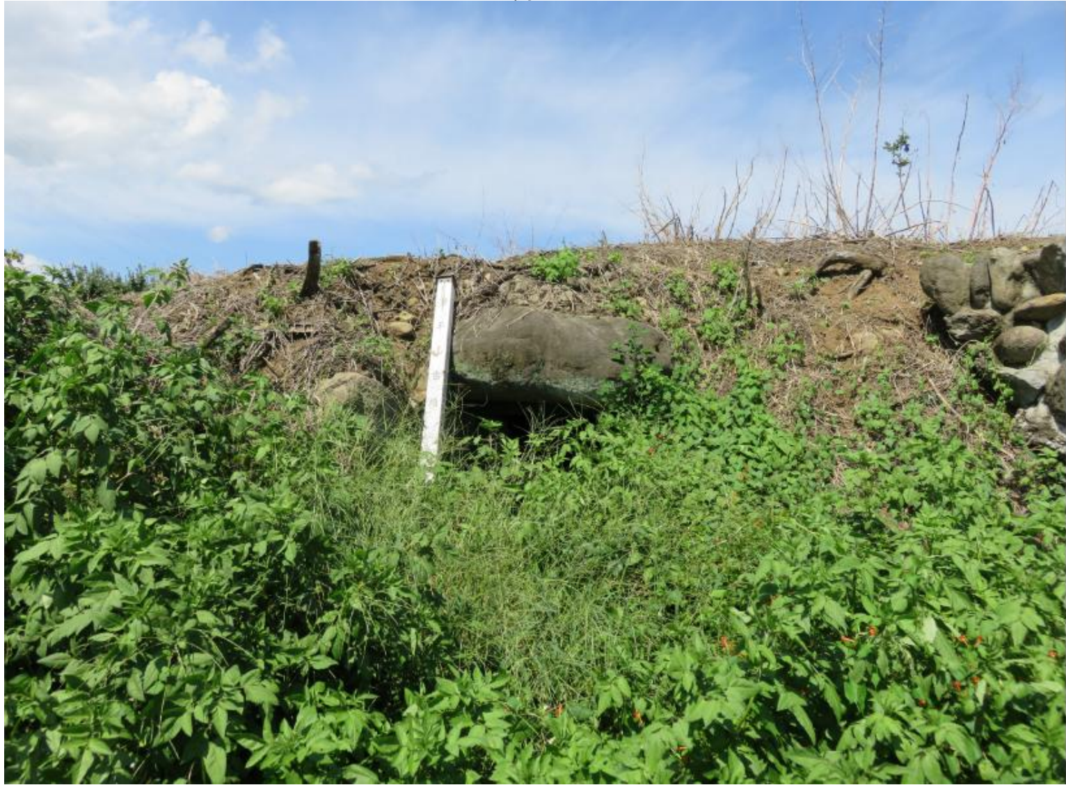
石室が開口している
