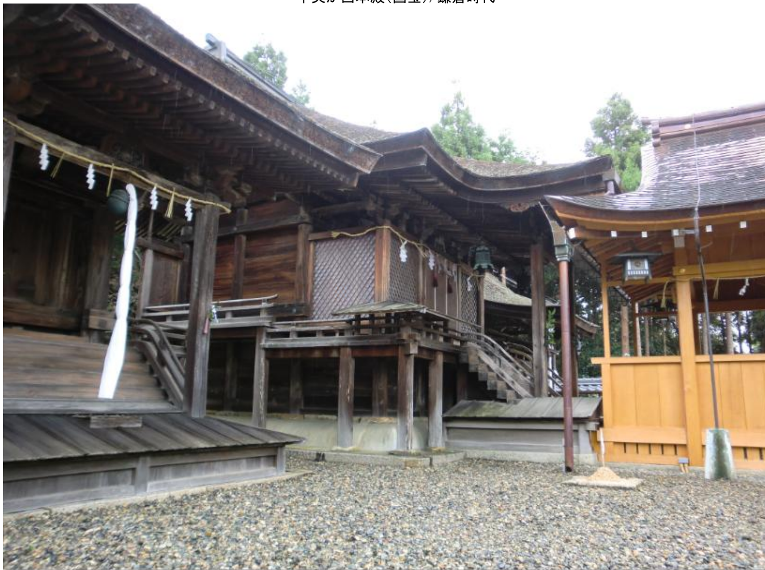
三間社流れ造り/屋根は檜皮葺き
