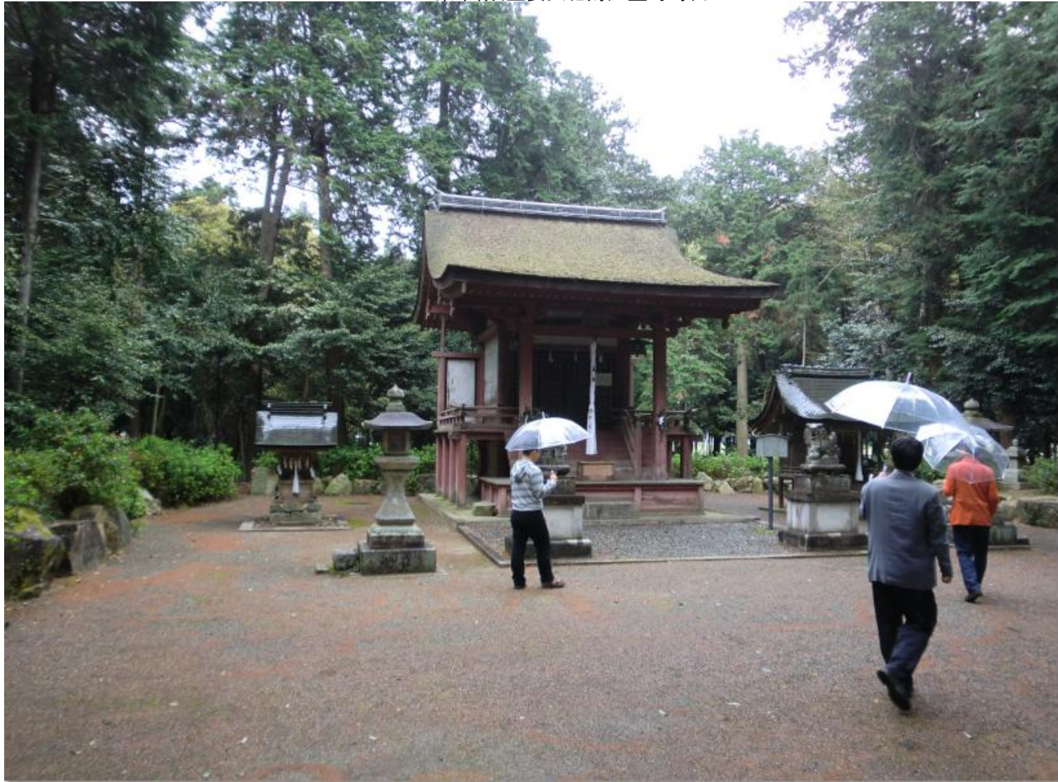
一間社流れ造り/屋根は桧皮葺き
