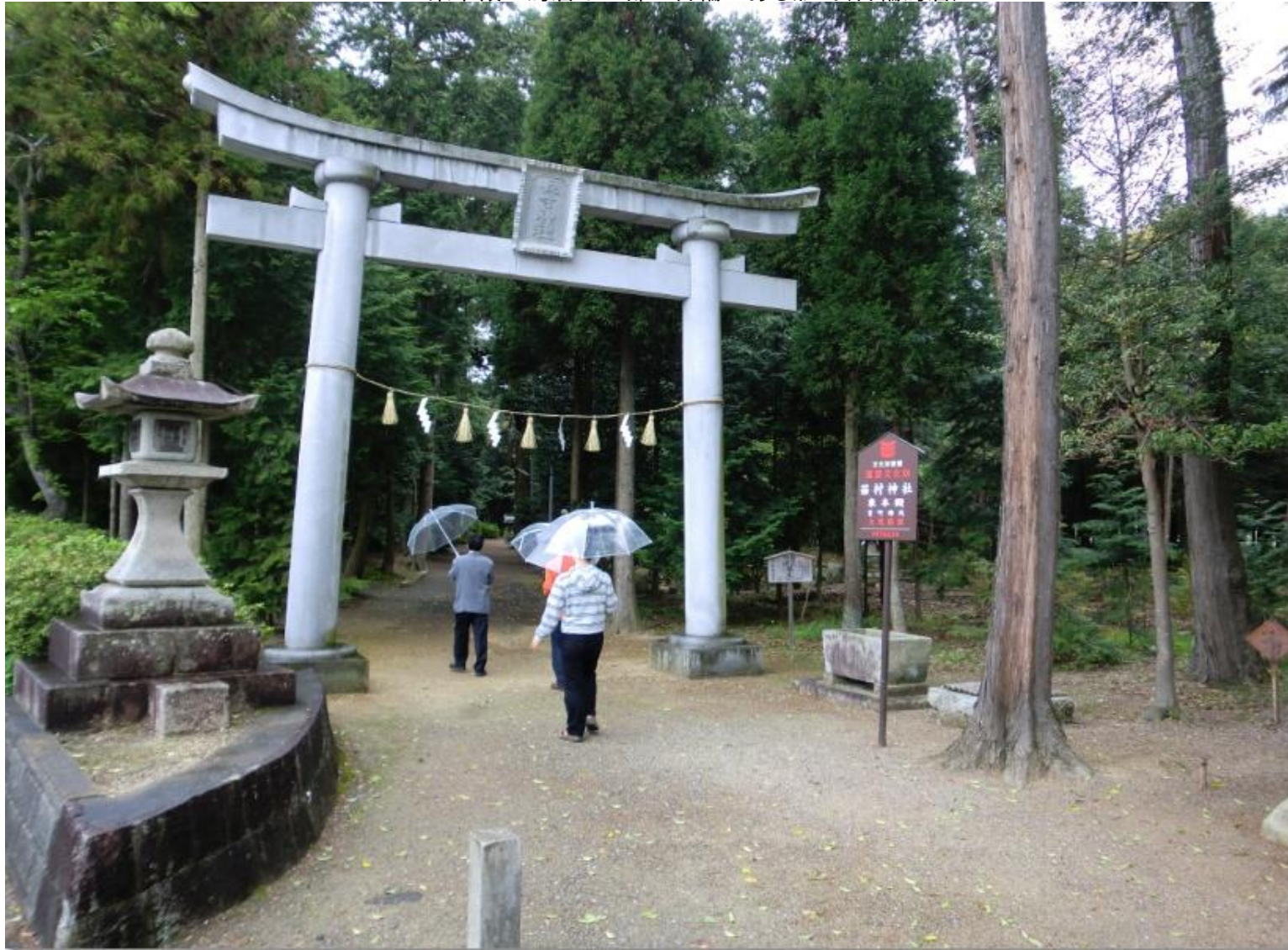
この東本殿の鳥居は上部に台輪がある形式(台輪鳥居)
