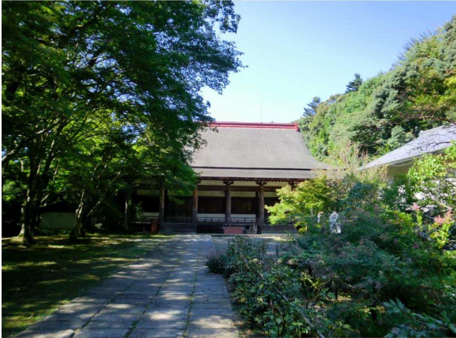
鍬葺きのように見えるが下層が妻へ廻り込んでおらず、庇(下屋)と捉えた方が良さそう(端部の拡大写真参照)
