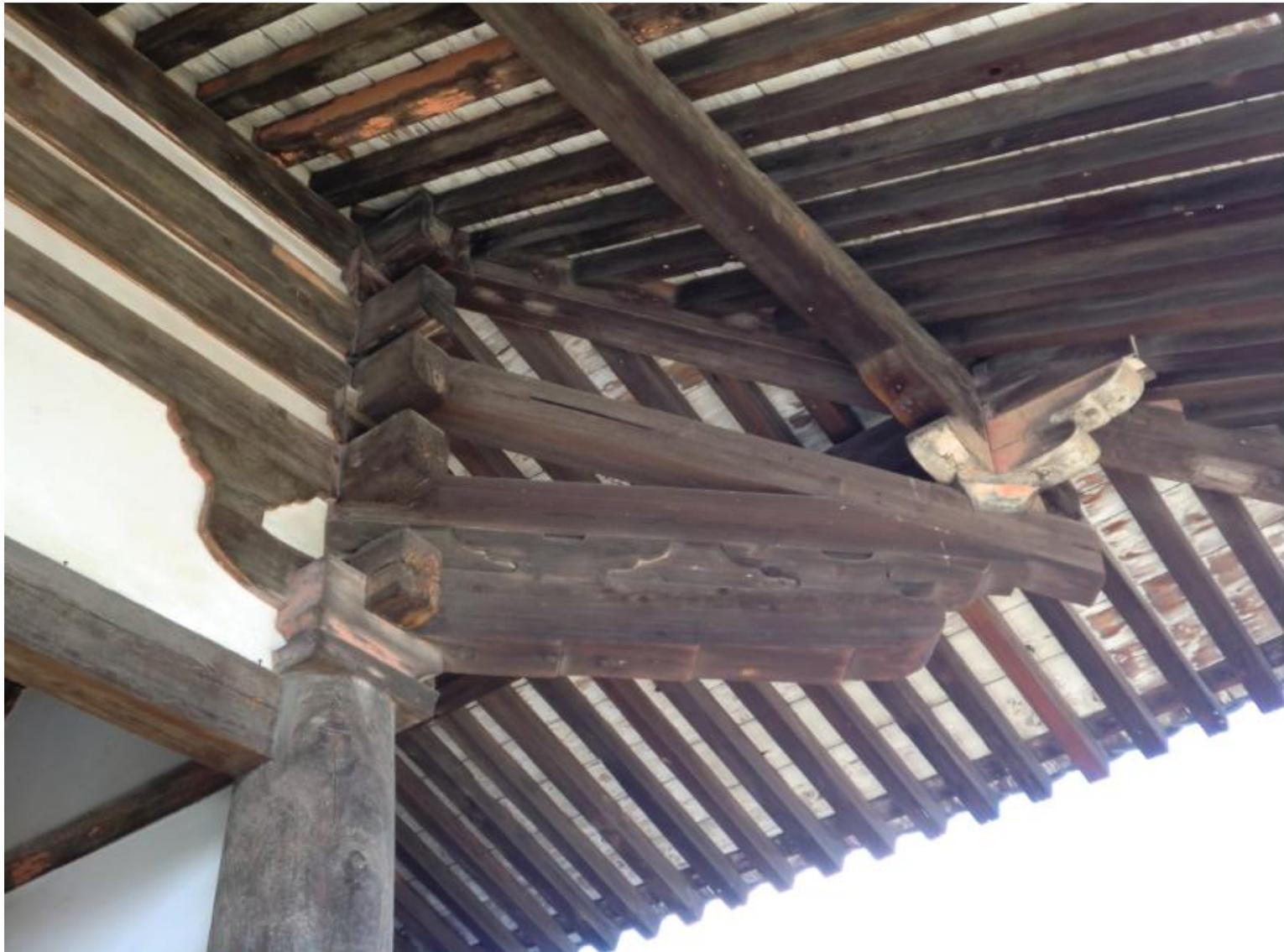
『皿斗とは柱と大斗の間に挟む四角形の厚板で大斗が柱に食い込むのを防ぐ効果的な技法であり、中国では続きますが我が国では間もなく姿を消します。
