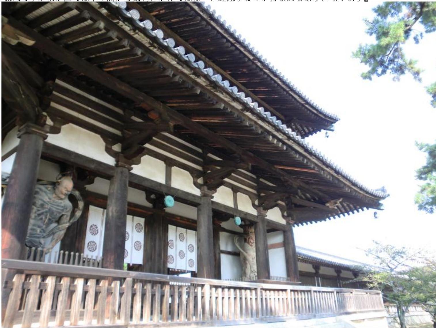
中の間に比べ脇間が極端に狭くなっているのは荷重の掛かる隅をたった隅木一本で支持するのに無理があるからでしょう。屋根を支えるのは垂木であり飛鳥時代は扇垂木であるのに我が国では写真のように隅部分では効果がない平行垂木に変わるのであります。大きな荷重の掛かる隅屋根の補強対策と中の間から脇の間へ柱間の遮減率を小さくするため、緑杵から一方、それから90度向こうにさらに一方の隅木、すなわち、90度の間に三方の隅木が出る技法が周知であるのになぜ法隆寺再建では採用されなかったのか不思議です。ということは、唐の新建築様式ではなく聖徳太子を偲んで古い飛鳥建築様式で再建されたということになります。我が国では天平時代を始め平安時代の建築は殆どが平行垂木で造立されております。
