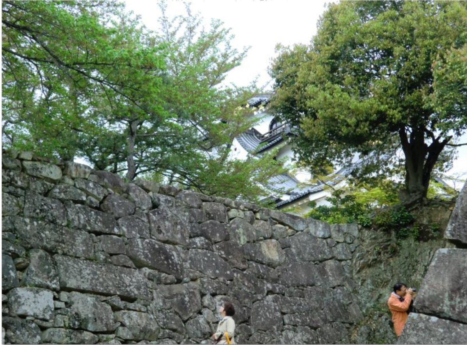
黒門橋へ下りる途上、天守を見上げたところ
