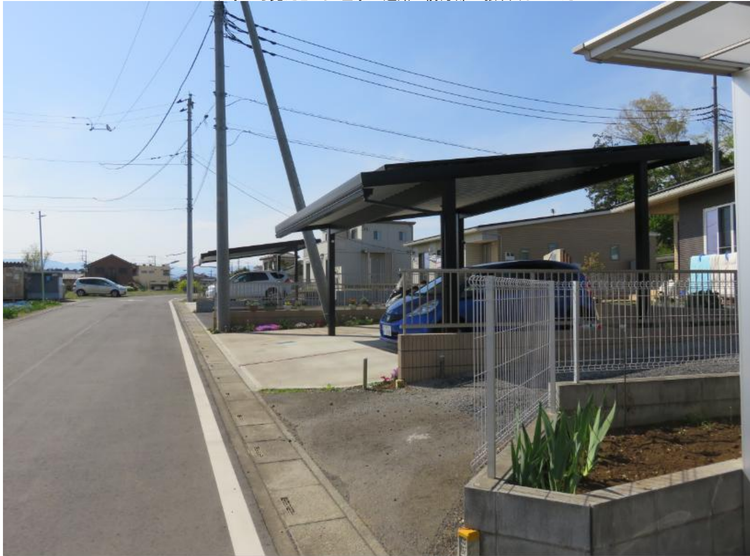
右手から見たところ/左手の道路に前方部が張り出していた
