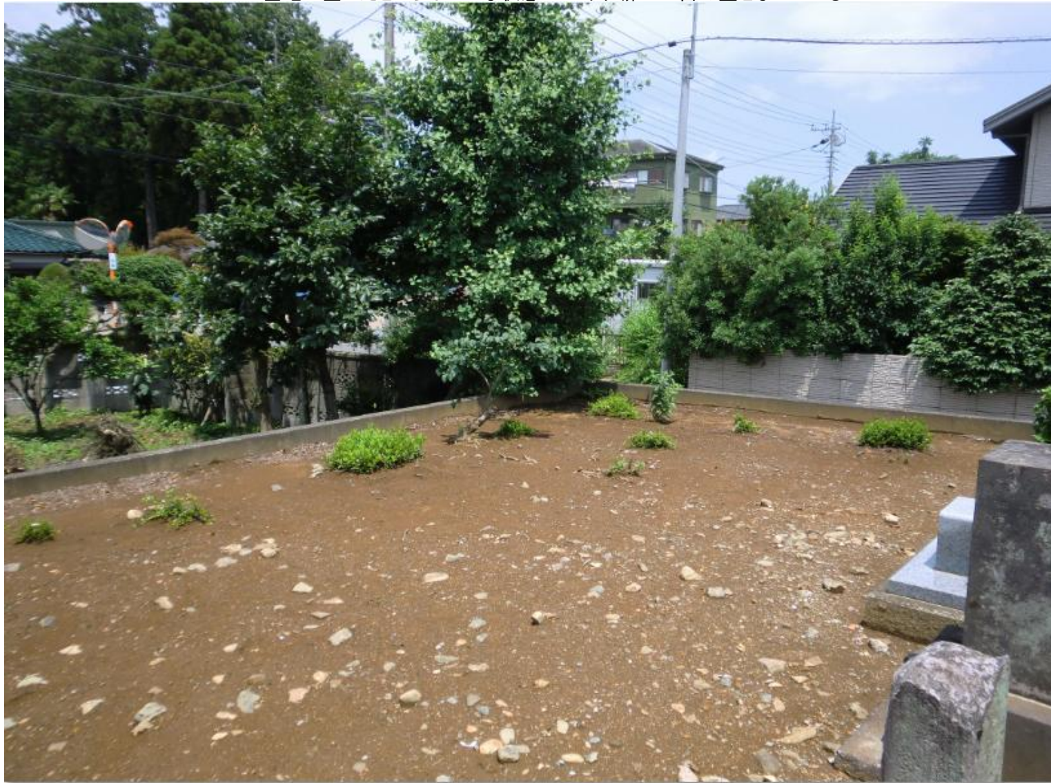
墓地に登ったところはこの状態/ブロック塀が土留め壁となっている
