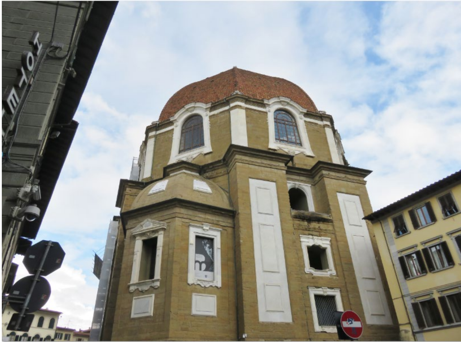
その上部を見たところ
