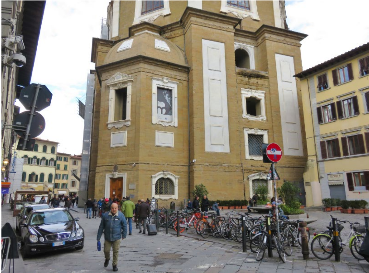
北側から見たところ
