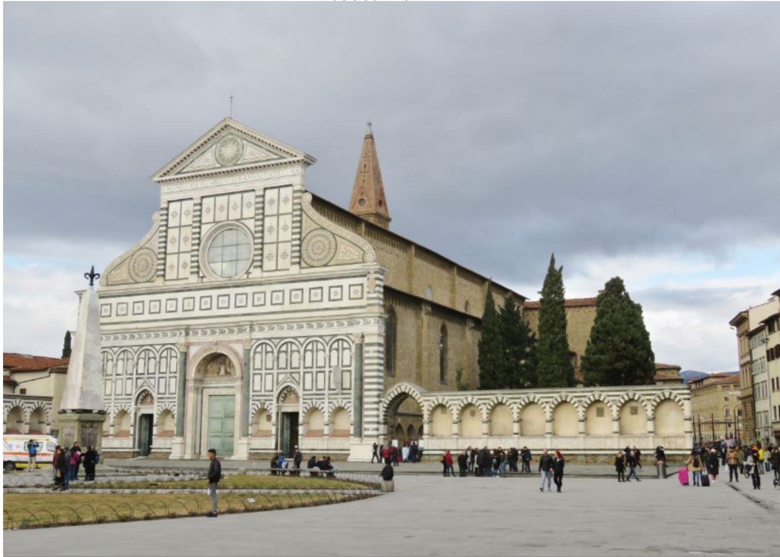
南東側から見たところ
